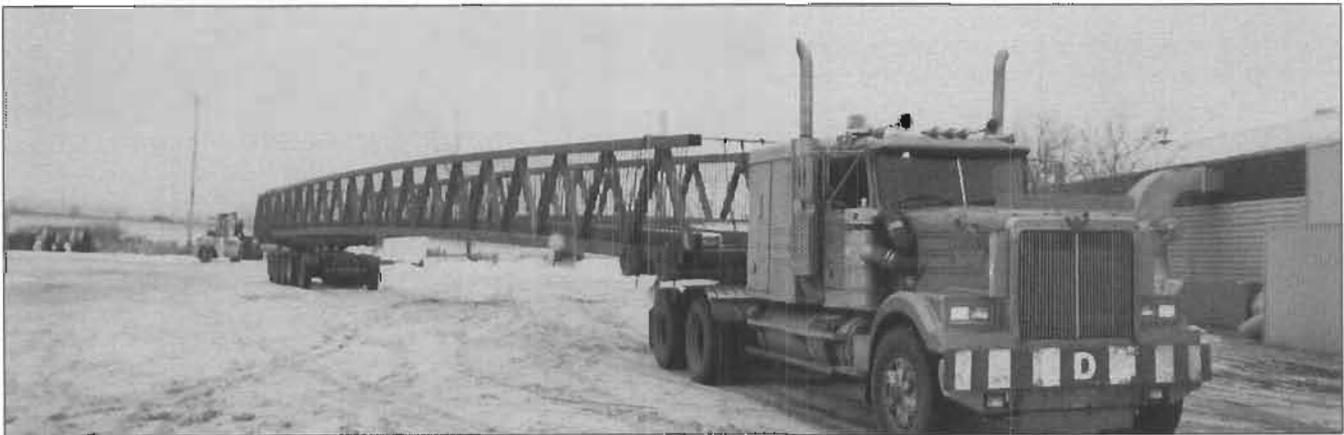
*Transport d'une passerelle de 120 pieds pour le canal Lachine à Ville Lachine (Montréal).
