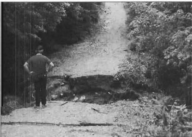
*Rang Saint-Frédéric: pont arraché, chemin coupé, perte des douilles de béton dans la rivière. Douilles introuvables*
