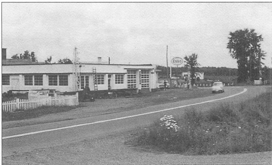
À l'été 1958, le garage et la jolie clôture de la résidence vus de la bretelle qui reliait la Route 5 (Route 116) au Chemin Craig (Route 269)
