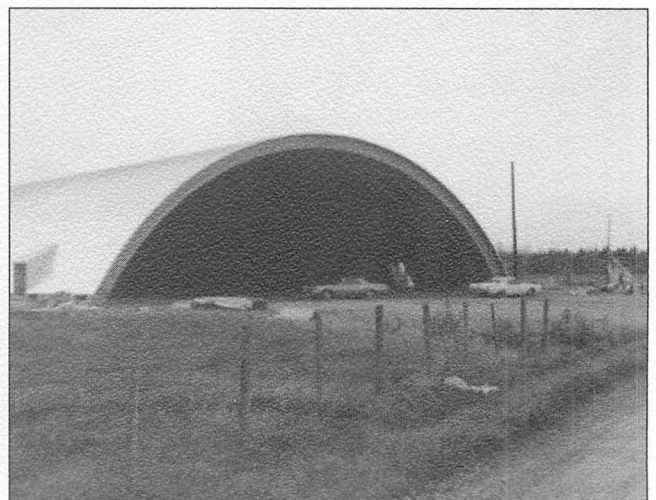
La couverture est complétée.
