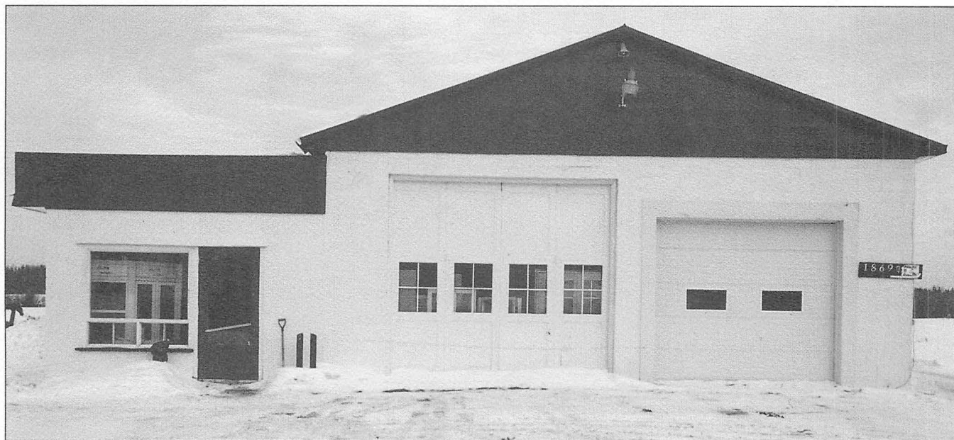
Local situé au 1869, rue Principale
