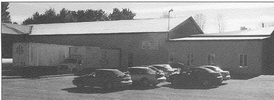
Vue extérieure (usine 2) en 2002
