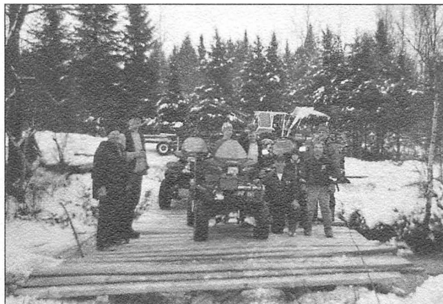
Réalisation d'un pont à Dosquet en décembre 2002
