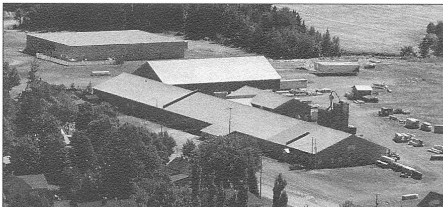
Vue aérienne (usine 1) en 2000
