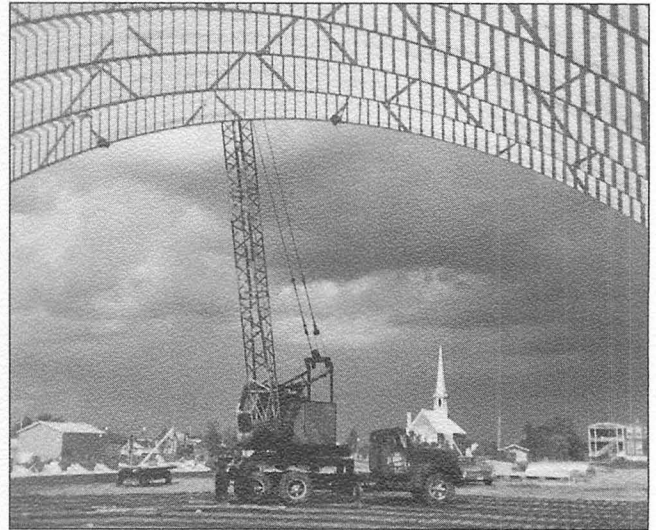
Les travaux progressent.
