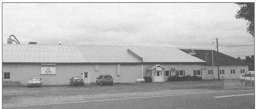
Vue extérieure (usine 1) en 2002
