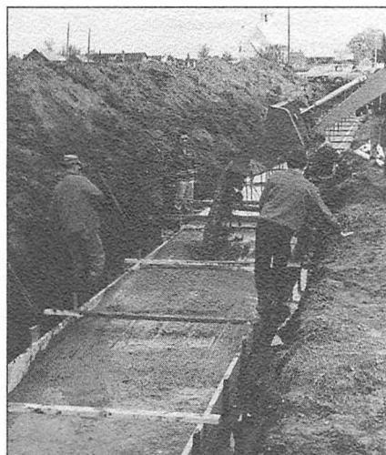
« Du bon ciment » fraîchement coulé pour les fondations de l'aréna. On peut reconnaître en face de la pelle Lorenzo Pelchat et Fernand Aubert.
