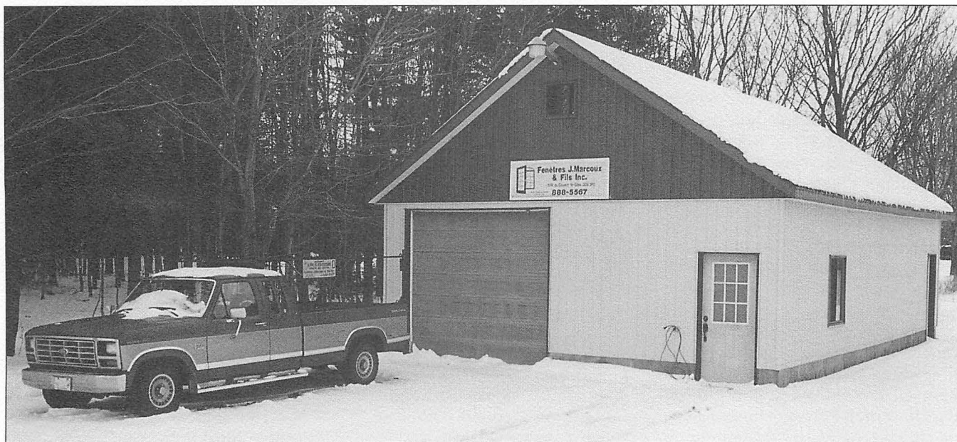
Local situé au 1574, rue du Couvent
