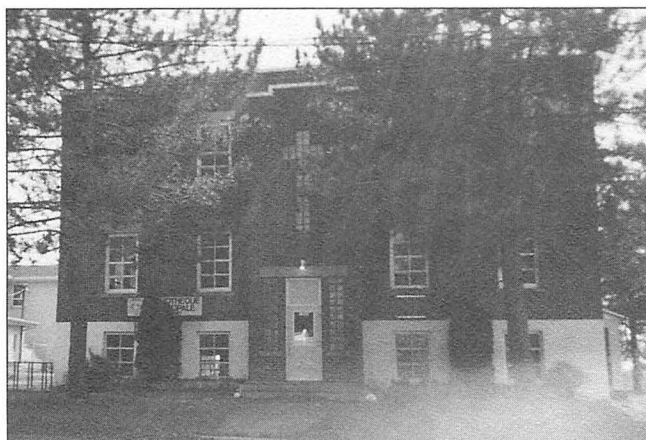
Couvent avant rénovation
