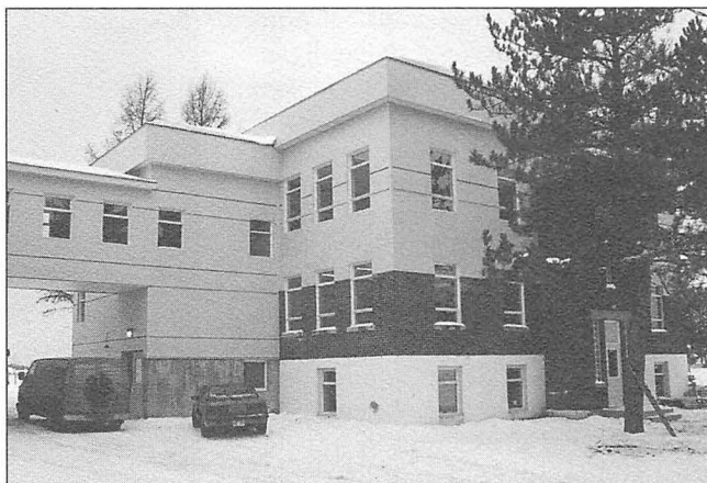
Couvent après rénovation
