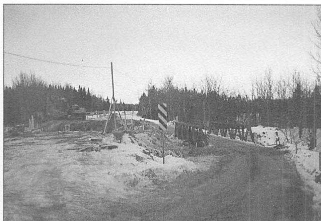
Le pont Galipeau construit en 1930 dans le rang Bras nord est déplacé pour servir de pont temporaire pendant la construction du nouveau pont
