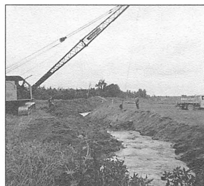
Les travaux de creusage de la rivière Le Bras, en juillet 1970
