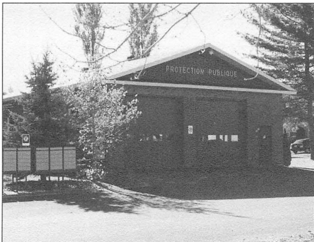
Édifice de la protection publique construit en 1969
