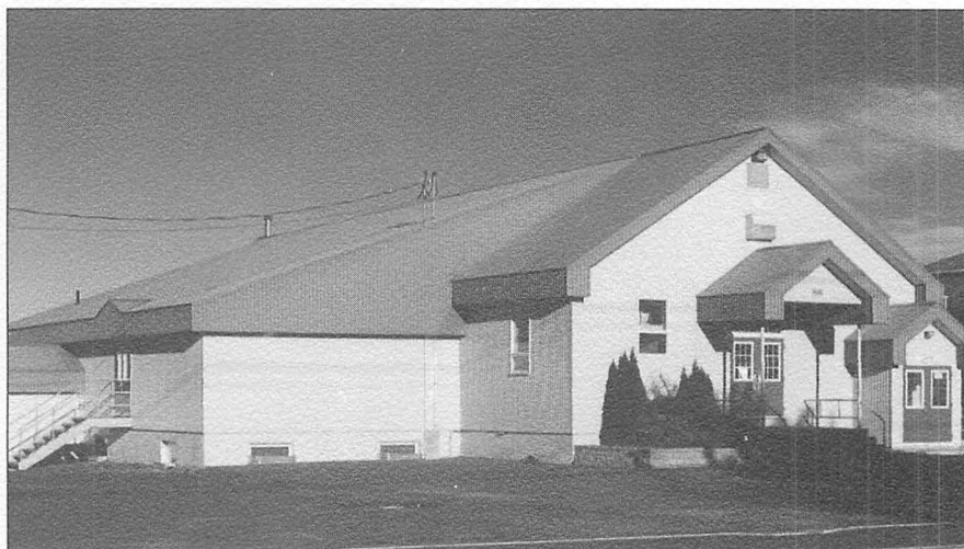
La salle municipale rénovée en 1994-1995
