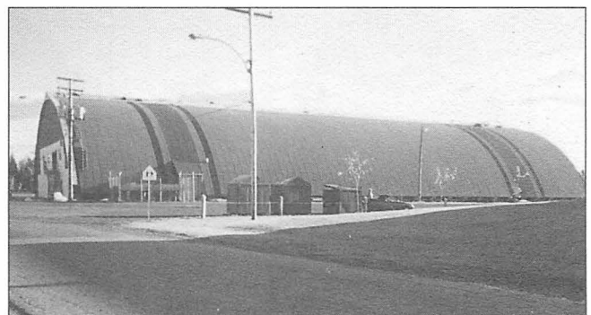
Réfection de la toiture de l'aréna, en octobre 2002
