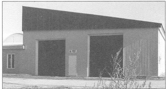
Garage municipal aménagé en 2000 dans l'ancien édifice de P.A. Martineau ltée
