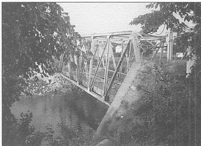
Démolition du pont Francoeur en 1997
