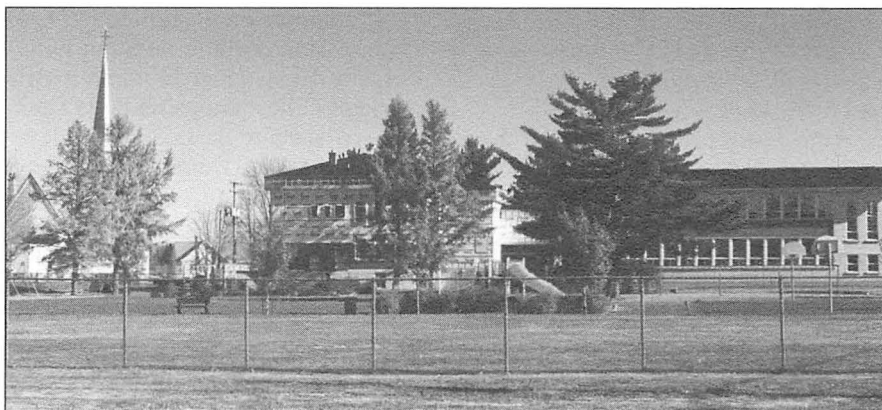
Le parc de l'école Étienne-Chartier et la rénovation du couvent, en octobre 2002
