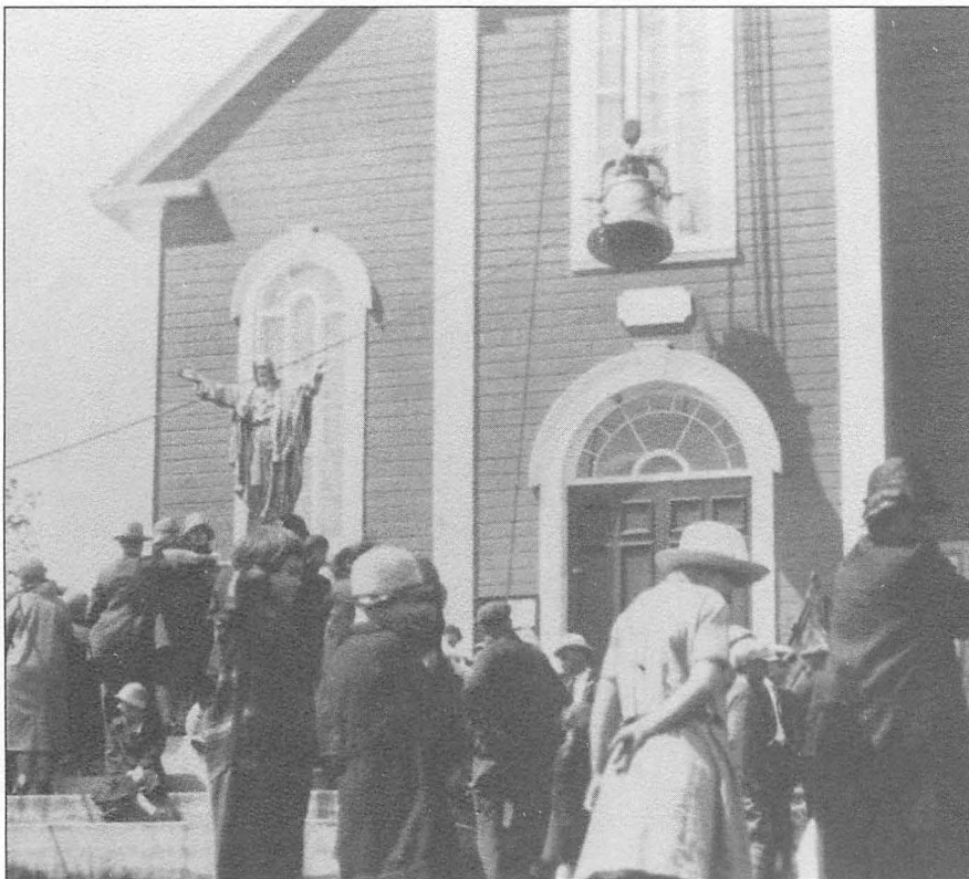
L'une des cloches est hissée jusqu'au clocher au moyen d'un palan.
