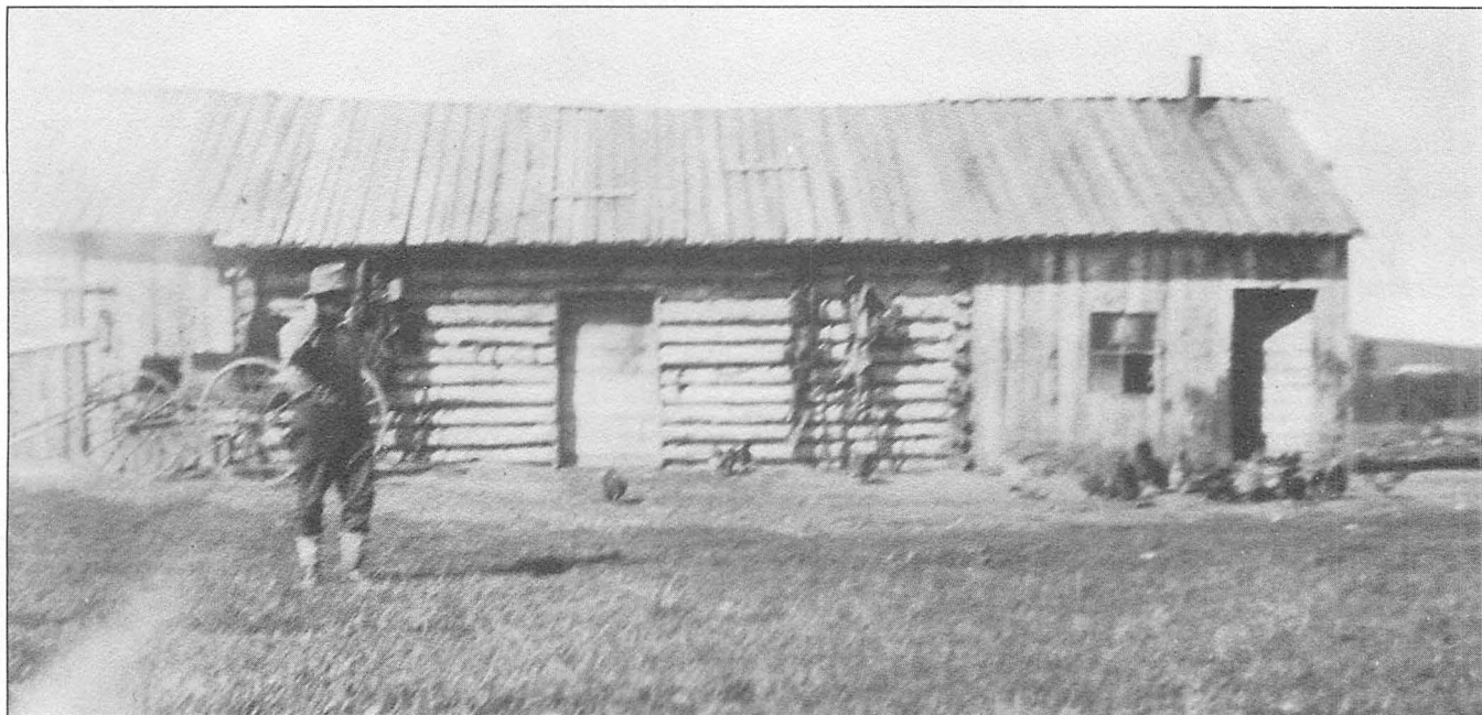
Première maison des ancêtres Shallow. Du côté droit, la maison; et du côté gauche, on gardait les animaux. Ce type de construction est typique des logis des premiers colons venus s'installer sur la Seigneurie de Saint-Gilles de Beaurivage.
