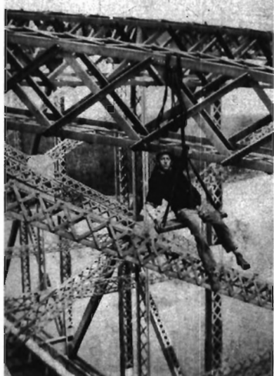
Peintre Léopold Bourassa lors de la construction du pont de Québec.
