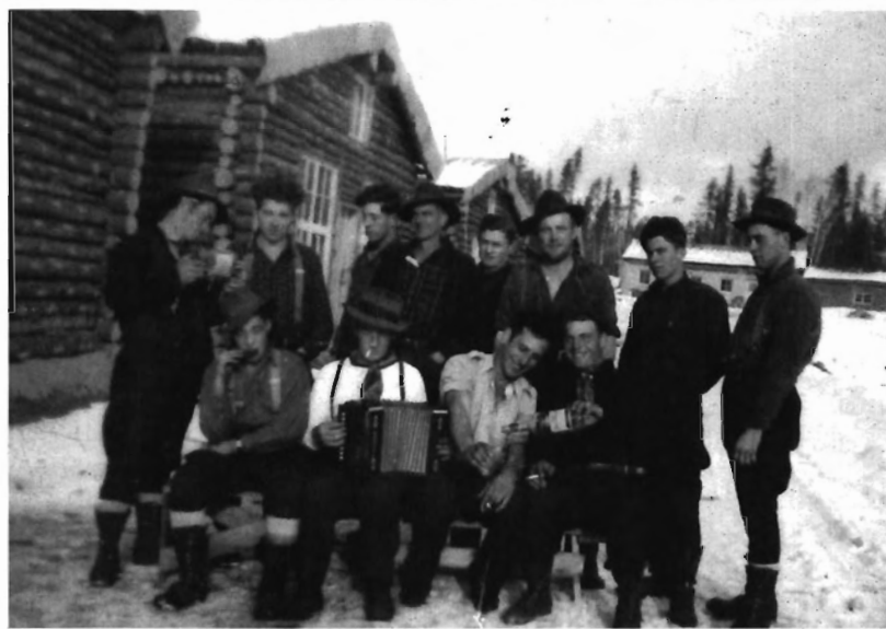
Les frères Côté : Paul-Henri, Armand et Welly au chantier.
