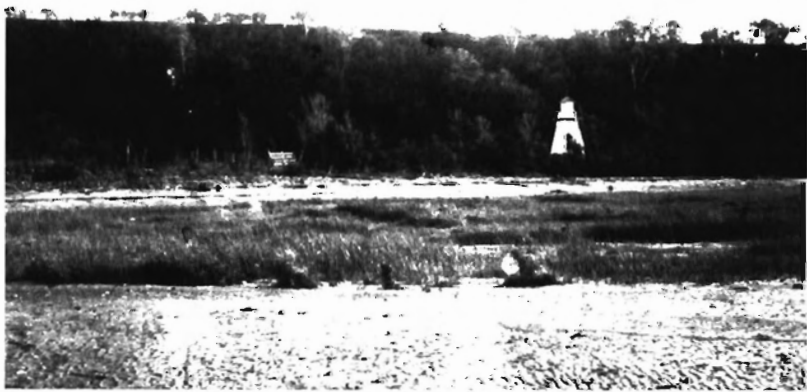
Emplacement du premier manoir sur la grève à Saint-Antoine-de-Tilly
