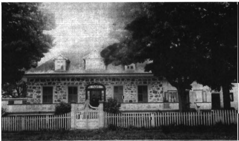
Le presbytère avant la restauration de 1912.
