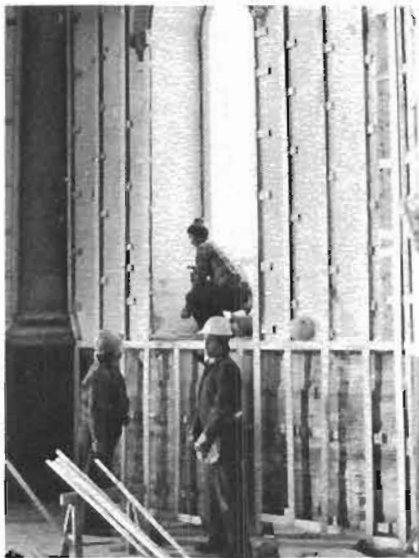
Le posage de lattes à l'église
