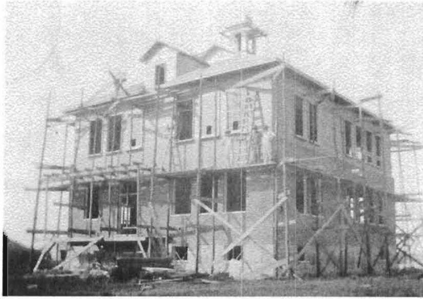
Construction du collège
