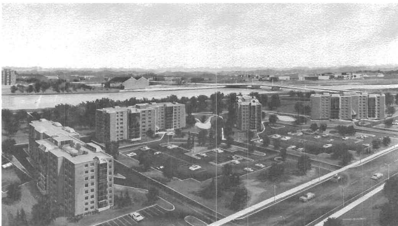
Projet en construction de 368 logis à Parkway Village
