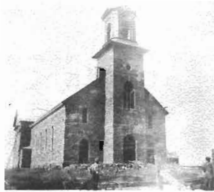
La construction tire à sa fin
