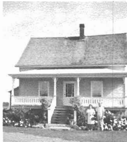
Résidence ayant appartenu à M. et Mme Desharnais, située au 215, Route 116 Est, à Dosquet
