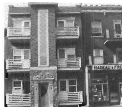
Épicerie et immeuble, à Montréal
