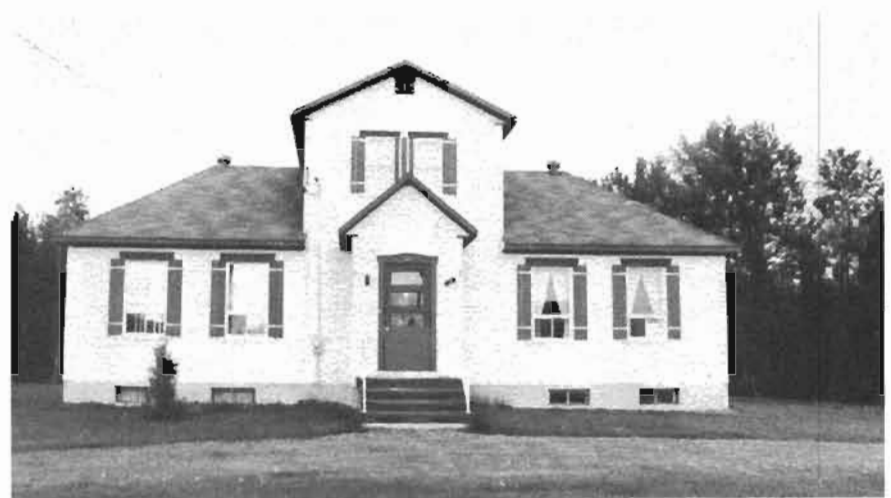
École de la route 116 Est, rénovée
