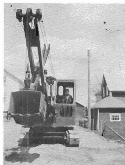
Ulric avec l'excavatrice, en 1950
