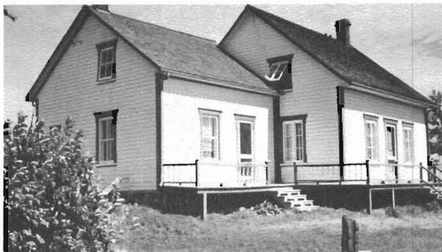
Maison datant du début du siècle dans le rang Saint-Joseph Nord
