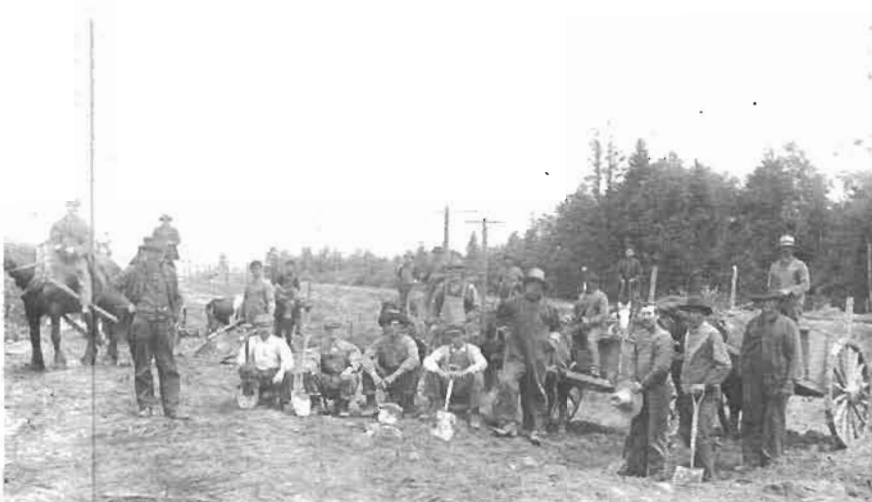
Construction de la route 5
