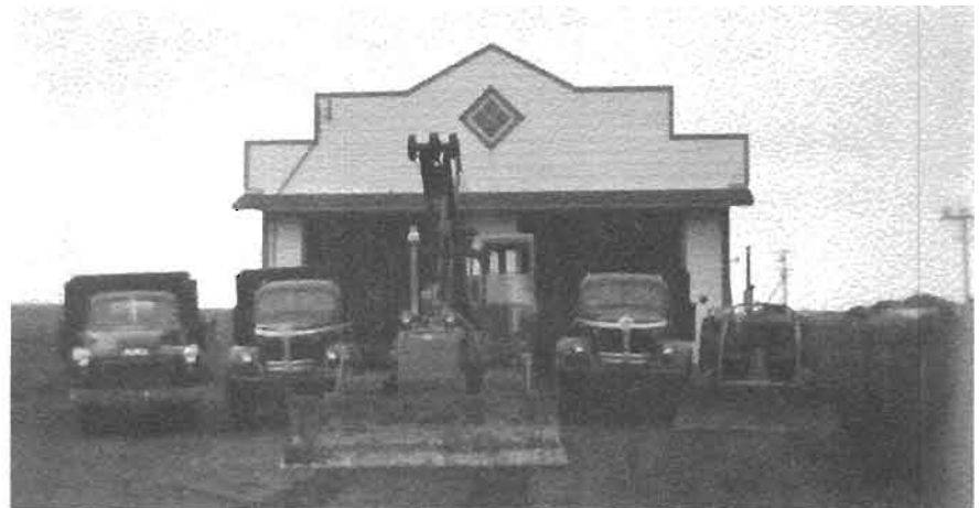
Camions de transport et de déneigement ainsi que la machinerie servant à l'excavation
