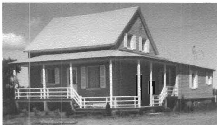
La résidence rénovée, en 1986
