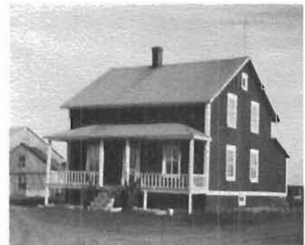
La maison familiale construite en 1942 et située au 51, route 116 Est, à Dosquet
