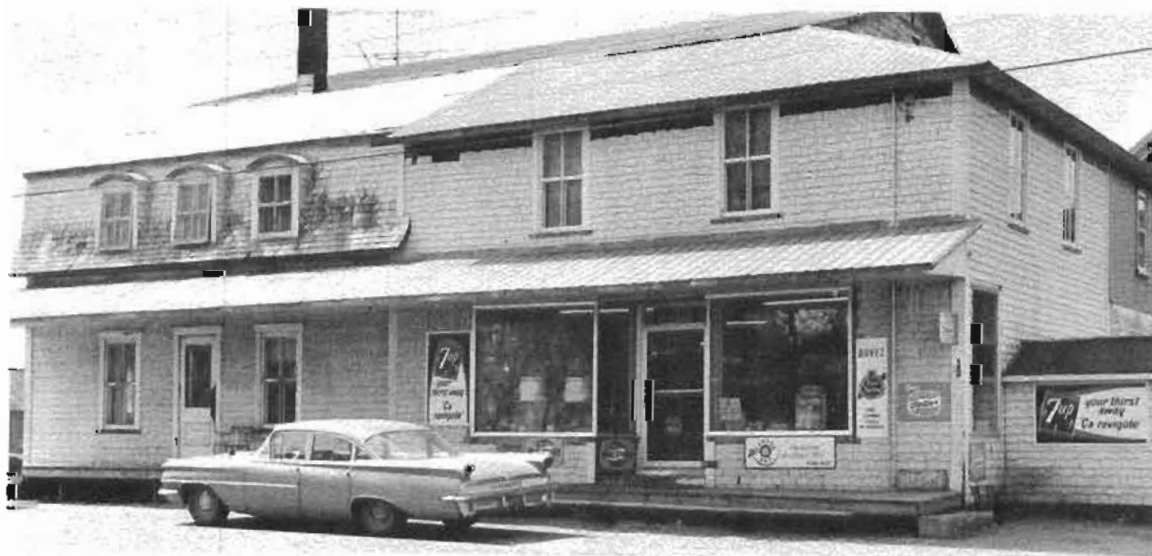
La maison familiale attenante au magasin général
