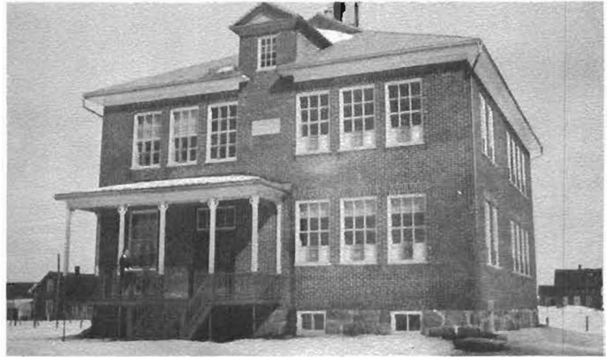
Le collège terminé
