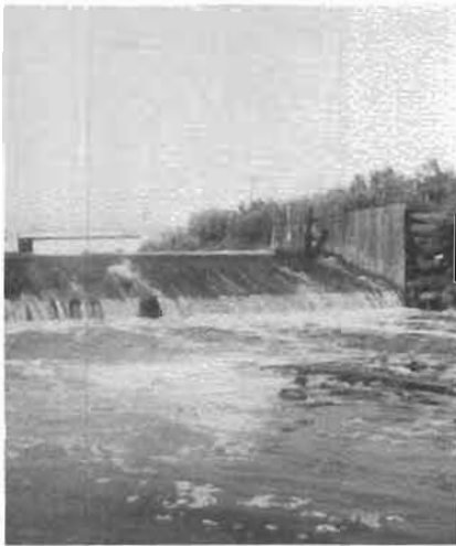
Barrage sur la rivière Henri
