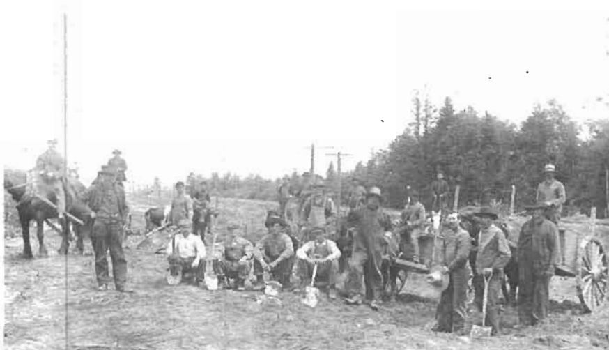
Construction de la route 5
