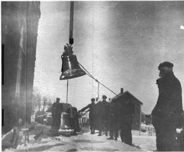
Installation des cloches
