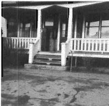
Bureau de poste chez M. Rémi Croteau
