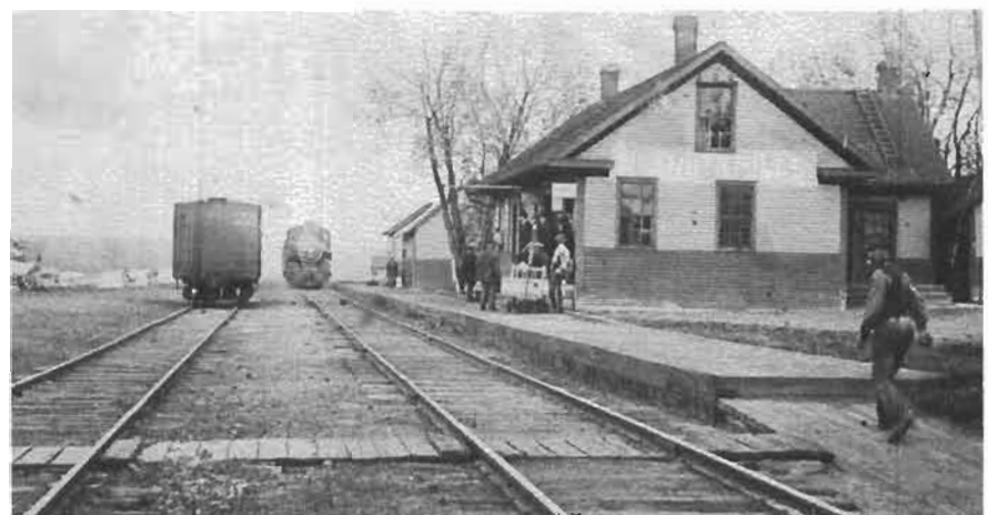
Station de chemin de fer à Méthot's Mill
