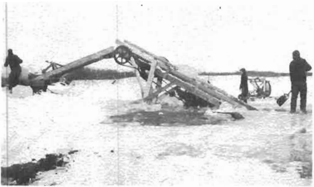
Montre-charge sortant les blocs de glace
