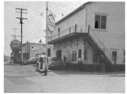
Garage rénové en 1962
