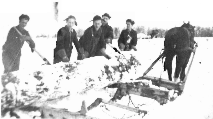
Chantier dans le rang Nord.
