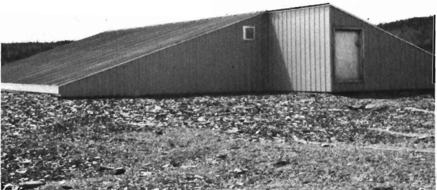
Abri du réservoir (nouveau).
