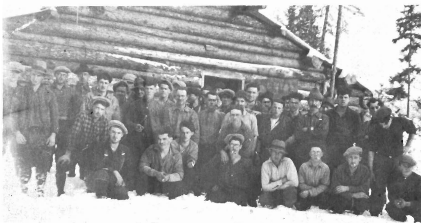
Chantier Allégaches, Maine, 1927-28.
