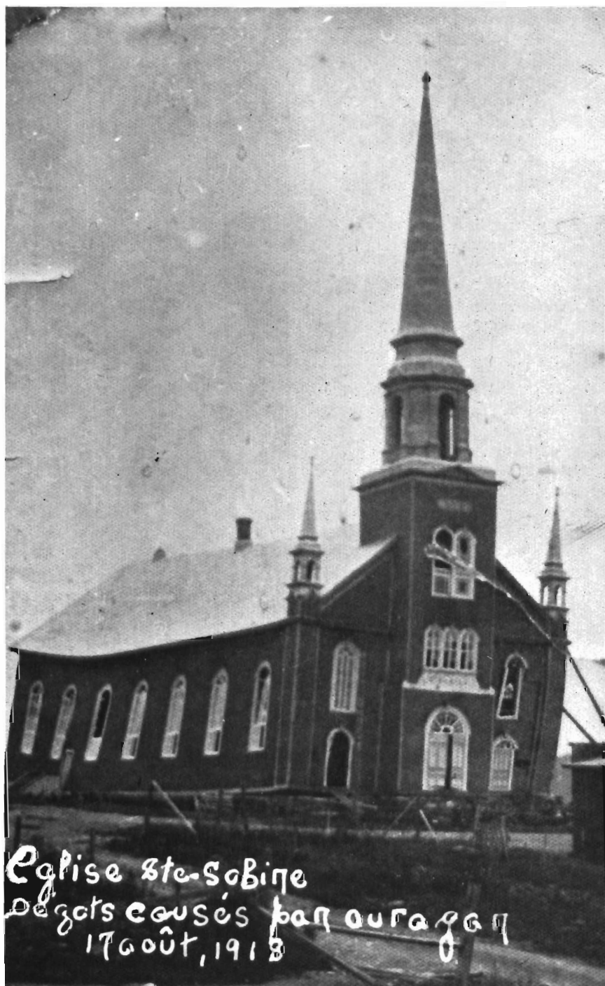
L'église après le cyclone (photo prise le 17 août 1918).
