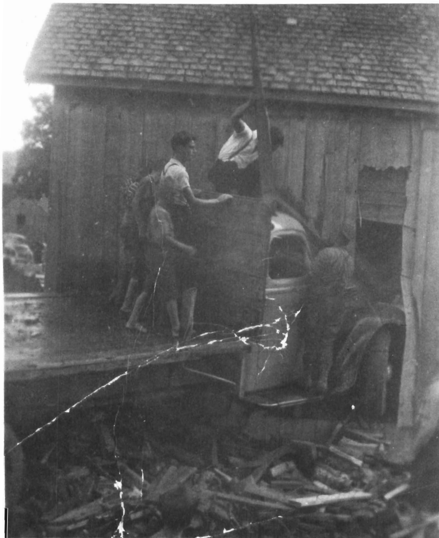
Maison de M. Henri-Louis Boucher, après l'accident.
