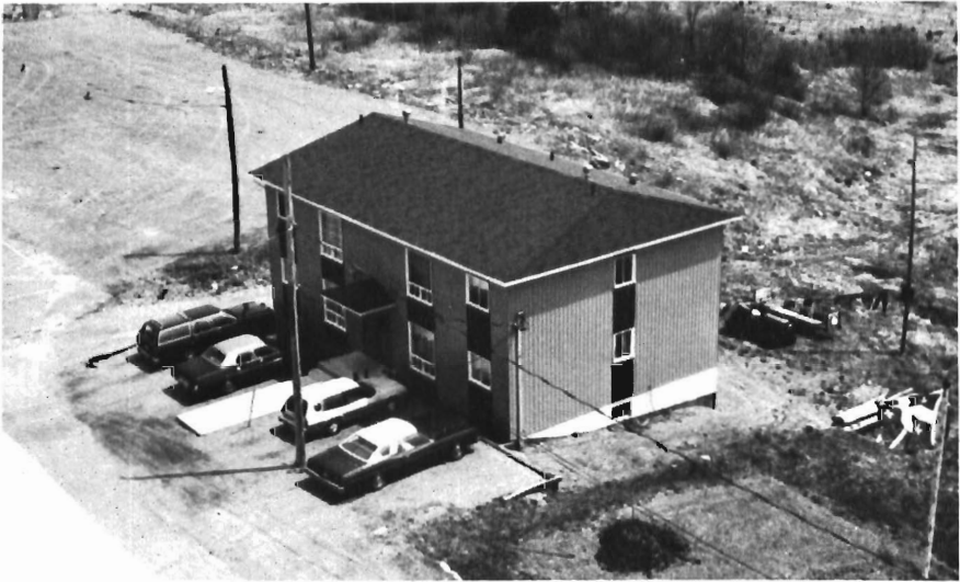
Immeuble d'appartements, construit en 1978-79.
