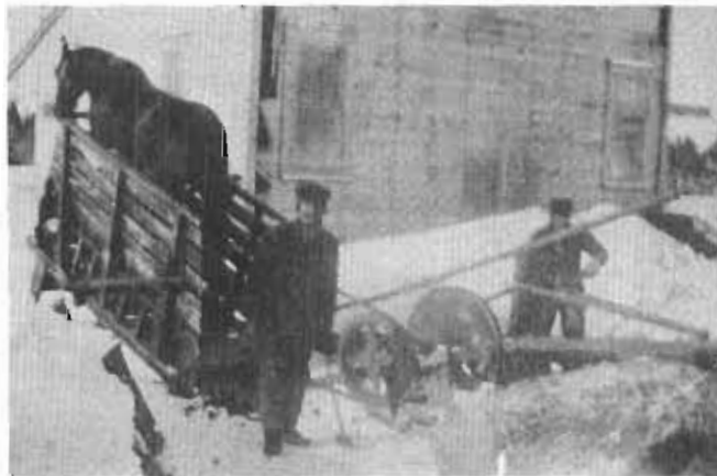
Pour couper le bois de chauffage, la scie (appelée zigonneau) est actionnée par un cheval (horse power). M. François Larivière et son père M. Honoré Larivière père.
