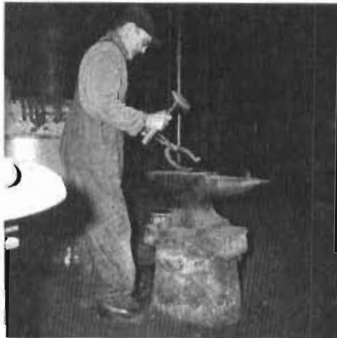
M. Goupil forge ce fer pour l'hiver. Une pince est soudée à l'avant du fer et les deux bouts sont recourbés.
