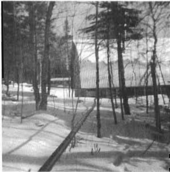
La modernisation a amené le système de tubes.
