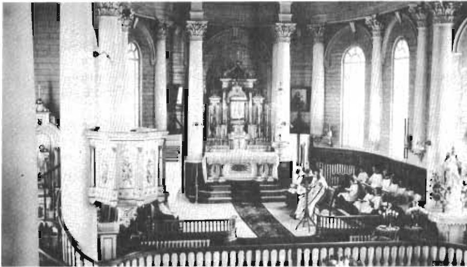
La chaire de notre première église est un don de l'Hôpital Général de Québec.
