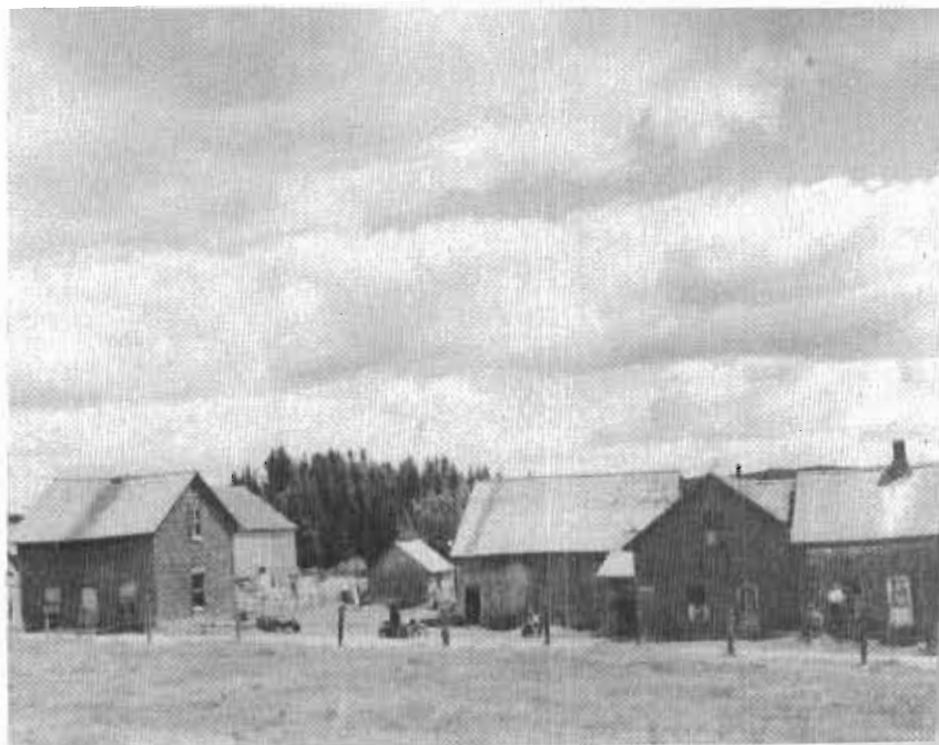
Maisons d'Alfred et Edgar Cormier, construites vers 1910. Se situaient au rg 2.
