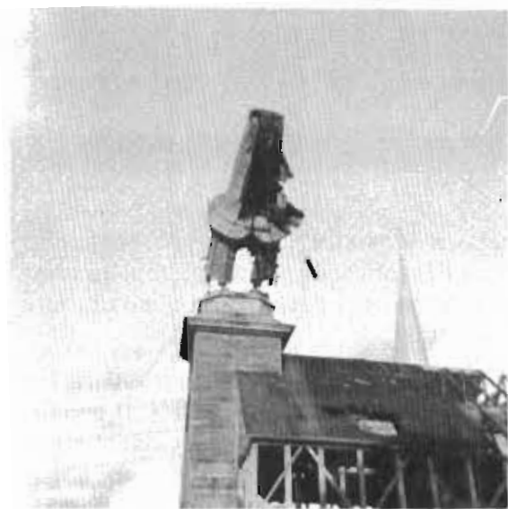
Démolition de la première église.
