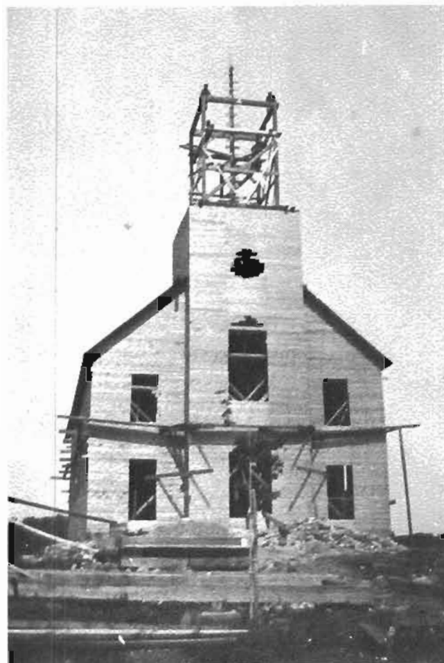
(3) Église en construction en 1925
