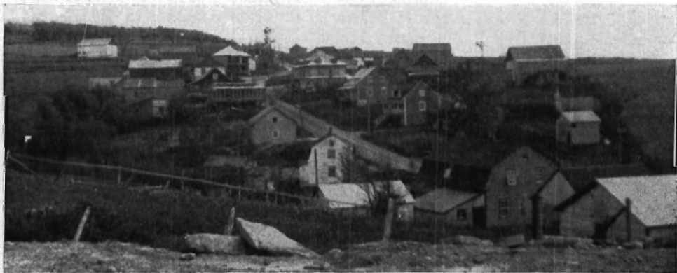
VILLAGE: Partie sud — (1941)
