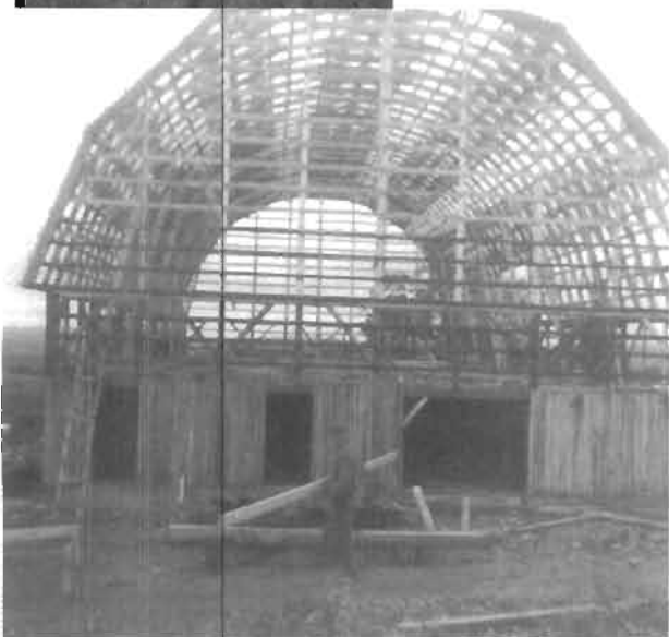
Construction de la grange, 30 juin 1962
