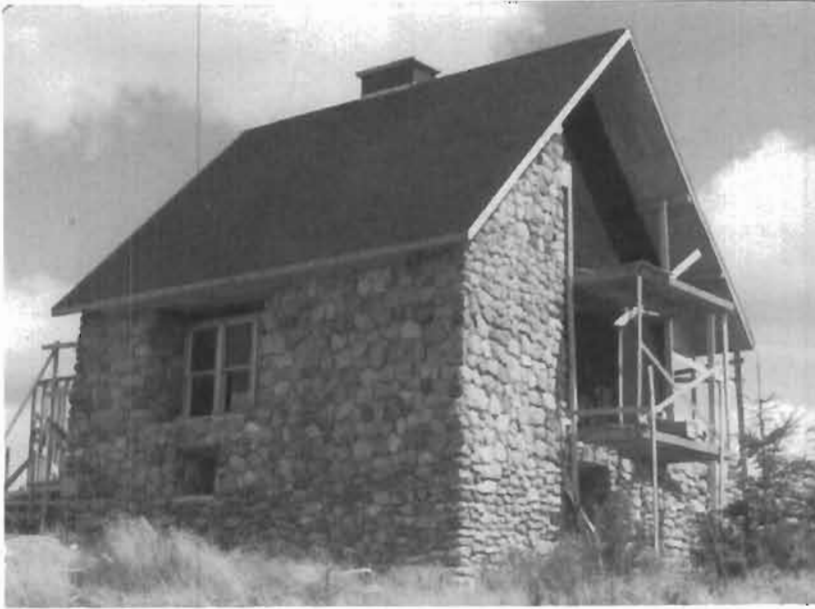
Maison construite par Henri Noël dans le rang 7 en 1973
