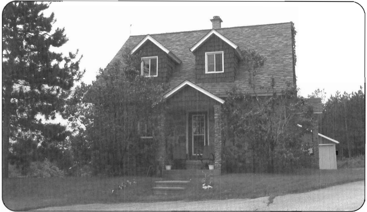
Maison ancestrale irlandaise restaurée par la famille Régis Carrier / Denise Guay Route Carrier - trois générations de la famille Rosario Laroche l'ont habitée avant la famille Carrier
