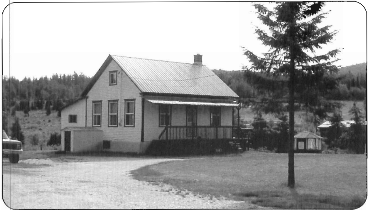
Maison d'école, route Chrétien, lot 79, transformée en résidence permanente.
