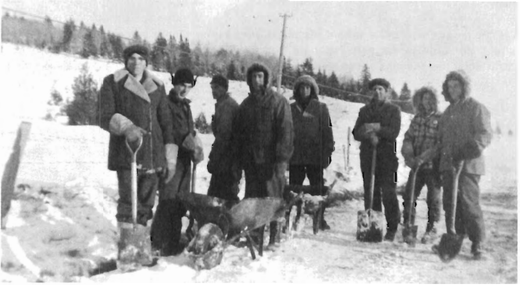
Travaux pour les chemins d'hiver. On creuse des fossés à la pelle, parfois on débroussaille. Les travailleurs sont de gauche à droite: Marcel Roberge, Paul Mathieu, Henri Croteau, Odilon Ferland fils, Jean Poudrier, Hervé Roberge, Claude Demers, Lévis Poudrier.
