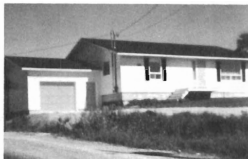
La maison actuelle a été construite en 1973, sur la ferme familiale, que Fernand a acquis en 1969
