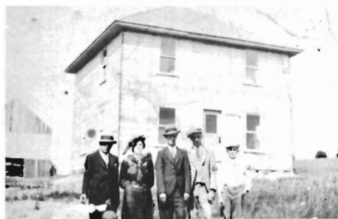
M. Mme Grenier, à gauche. Construction des bâtisses en 1935.
