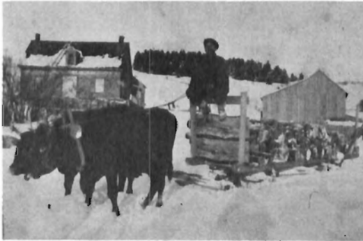
M. Arthur Carrier (Désiré) avec un voyage de bois de chauffage tiré par des boeufs, lorsqu'il était sur sa ferme située sur le Craig sud (aujourd'hui propriété d'Alphonse Gourdes). C'est M. Carrier qui a construit cette maison en 1933; elle n'est plus là maintenant.
