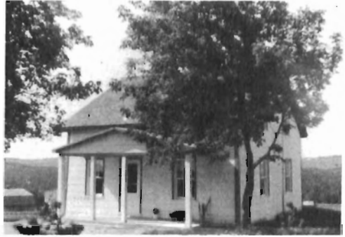
Antonio Carrier. A: plus de 100 ans. B: ?. C: 639, ce lot a été patenté en 1830. Cette maison est pièces sur pièces, équarries à la hache.
