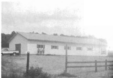
Manufacture bâtie en 1979
