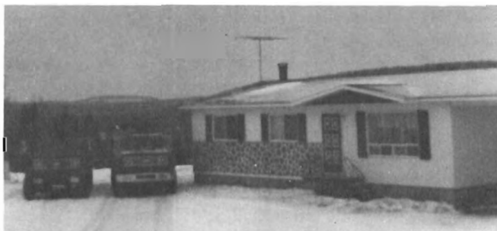
Maison familiale bâtie en 1973, suite à un incendie.
