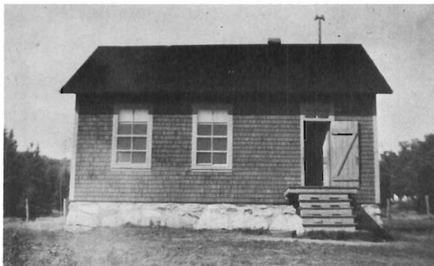
Ecole du Craig nord construite en 1943
