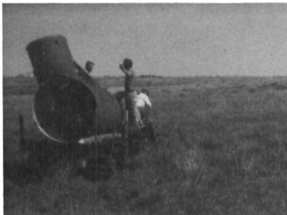
On voit sur la photo, le "boiler" de ce moulin que M. Carrier a retiré de sa cachette en 1975.
