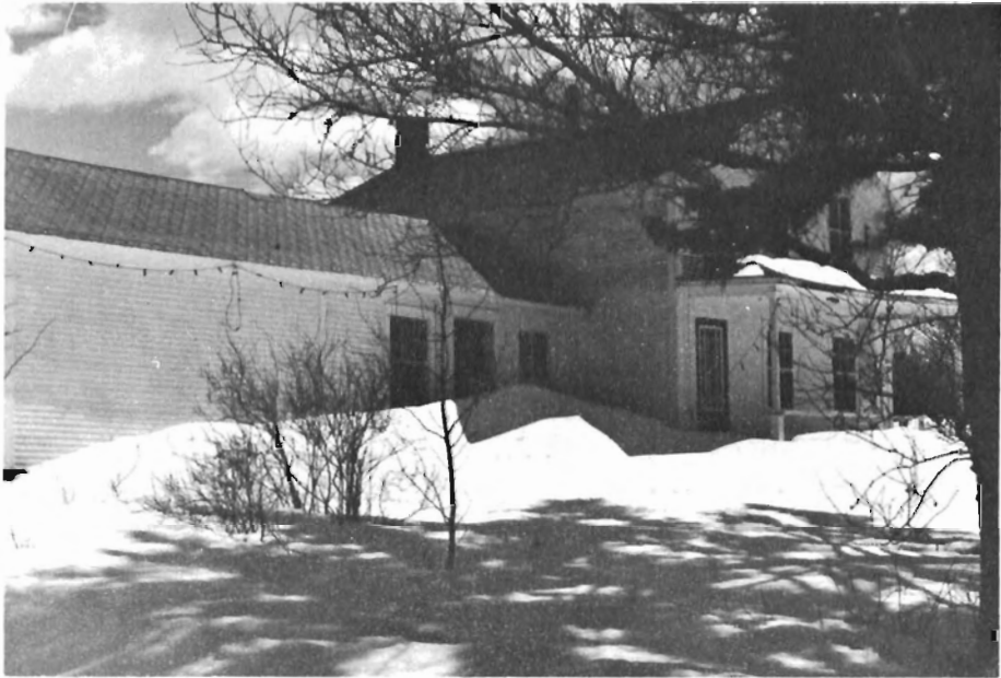
Maison construite par M. Porter vers 1830 sur le Craig Sud
