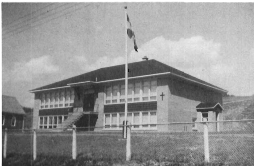
Ecole centrale construite en 1959
