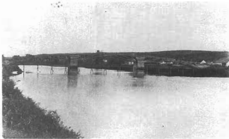
On peut voir le pont sur chevalets ainsi que, la construction du premier pont en bois permanent. -- Collection: Société du Patrimoine des Beaucerons
