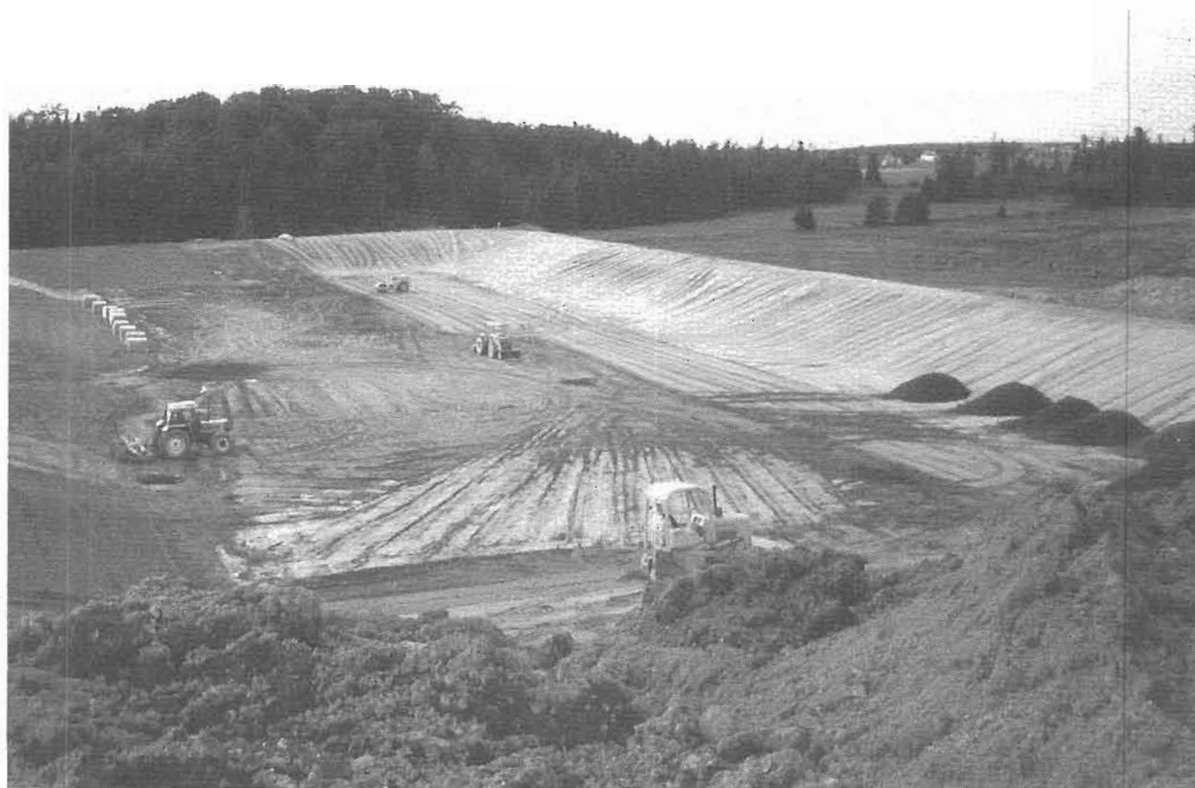
Construction des étangs d'épuration des eaux usées
