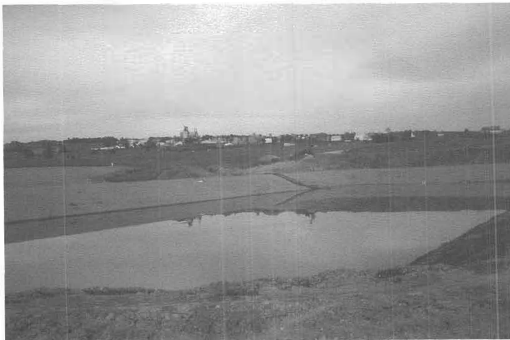
Étangs d'épuration des eaux usées
