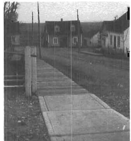
Construction de trottoirs en béton
