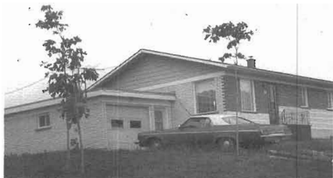
Maison de Dominique Breton, située 560, rue Robert
