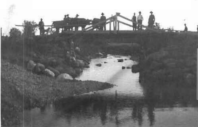
Construction du pont rang Saint-François
