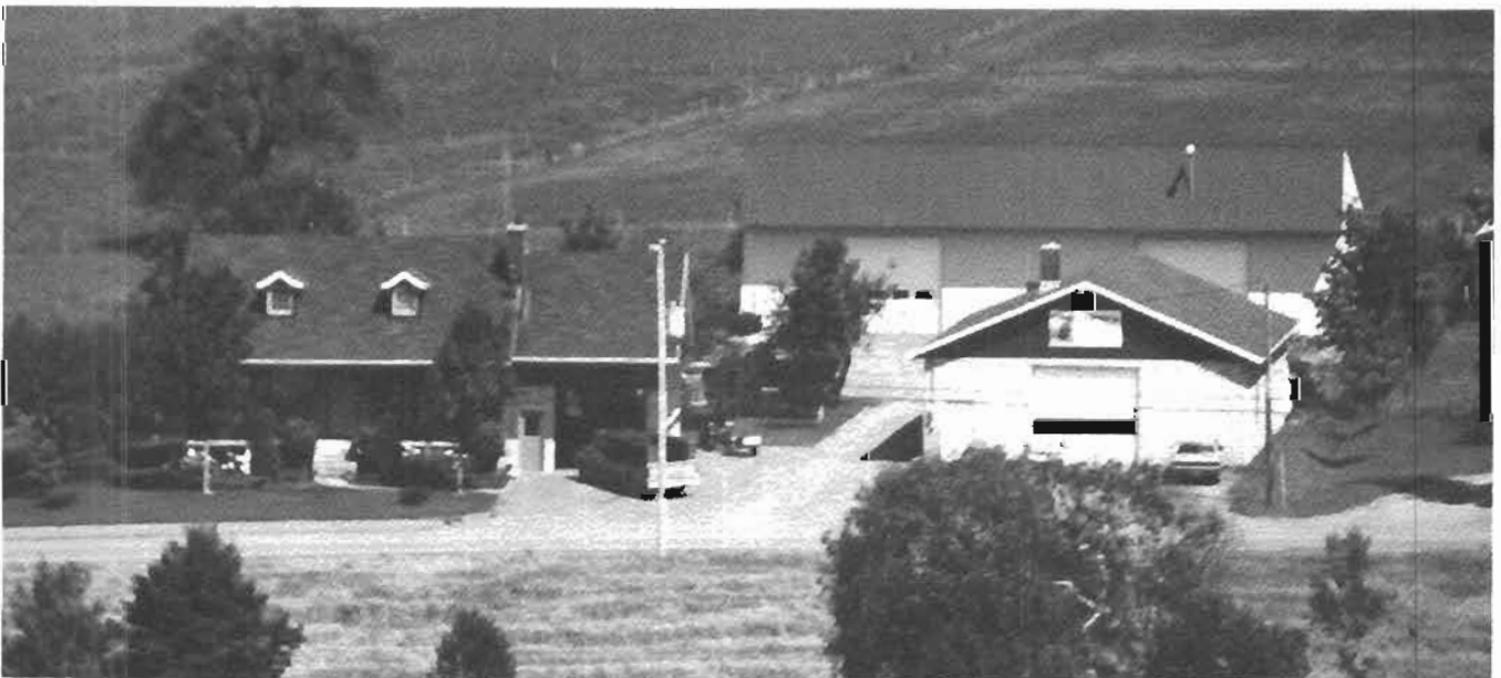
Résidence, garage et entrepôt
