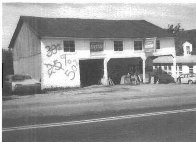
Démolition du magasin et de l'entrepôt, en septembre 1983
