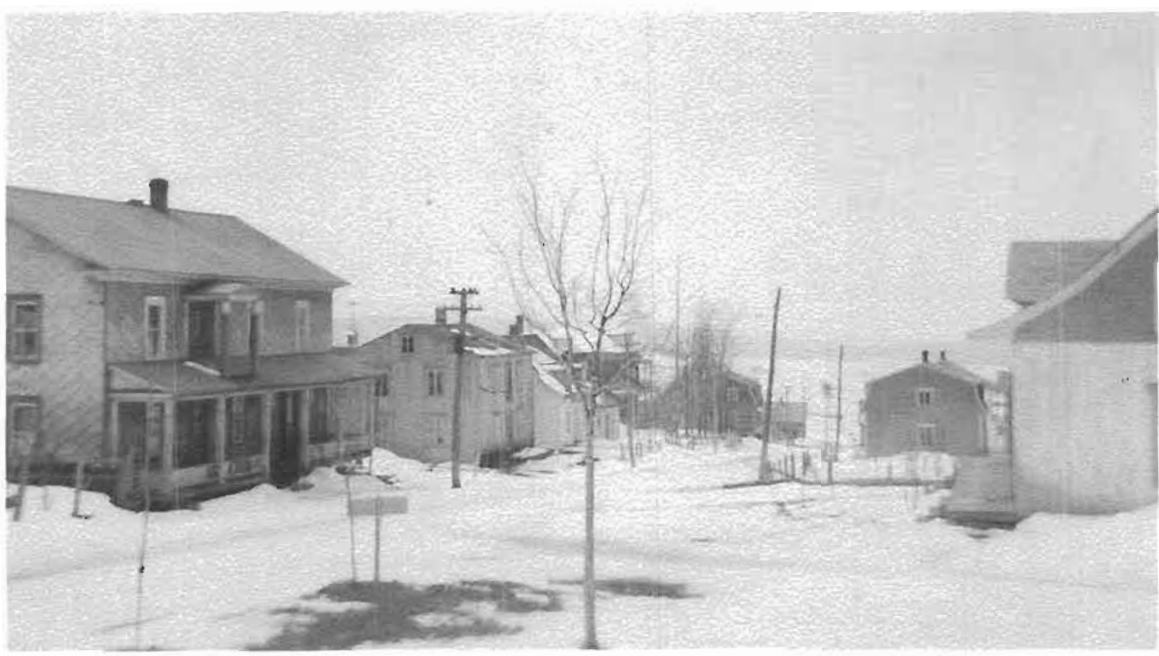
Installation des lumières de rue, en 1940
