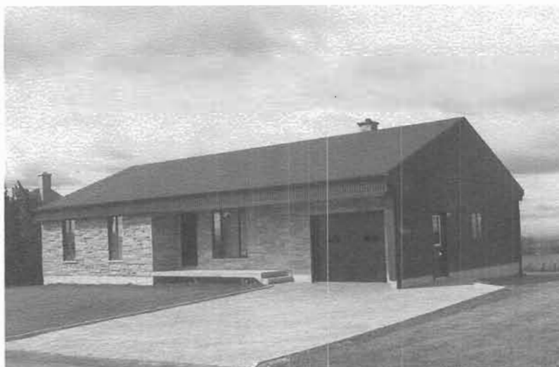
Résidence sur la rue Saint-Pierre
