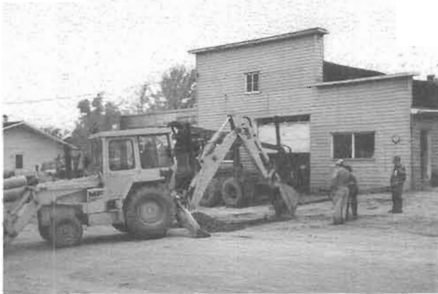
Travaux dans la rue Langevin
