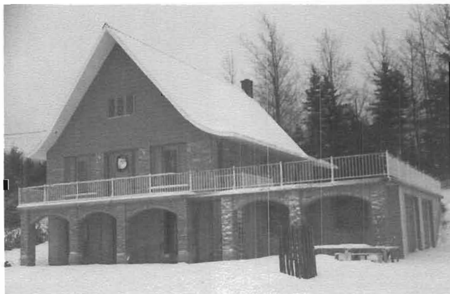
Notre maison actuelle, construite en 1984
