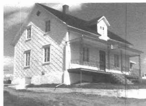
Première résidence qui a servi de magasin
