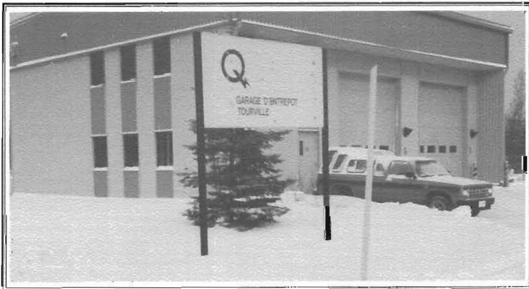
Depuis 1983, Hydro-Québec occupe ce garage et cet entrepôt à Tourville
