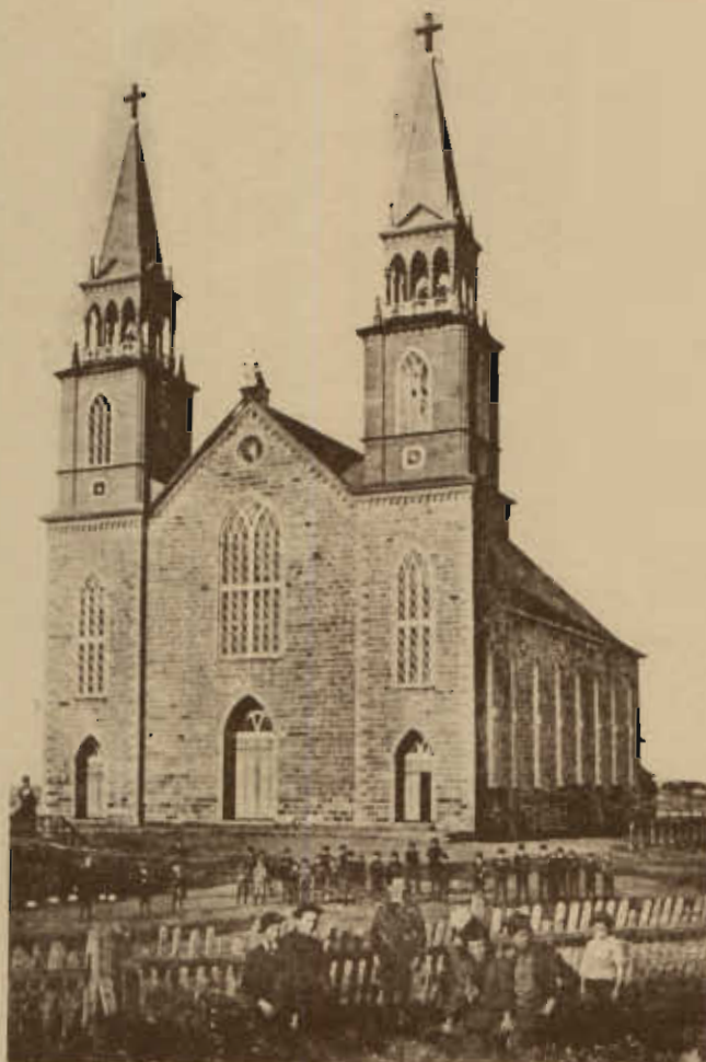
L'église de Saint-Roch telle qu'elle se présentait à la fin de sa construction
