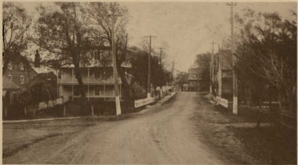
De l'église on remarque à gauche la haute demeure construite au début du siècle par Magloire Francoeur (propriétaire, J. Gamache). Photo: collection privée
