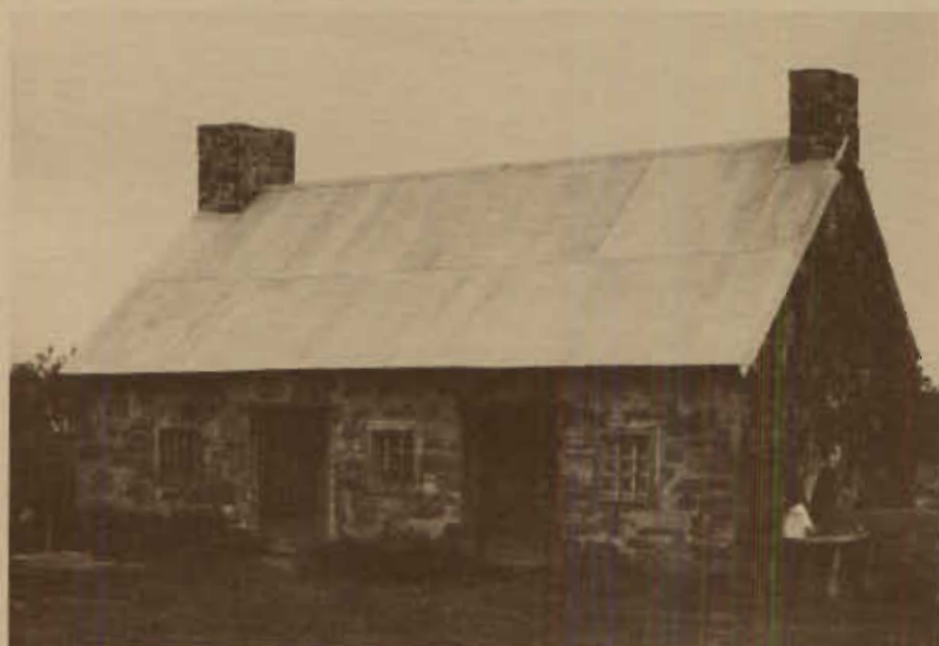
Petite maison de pierre du XVIII e siècle, appartenant à Mme Jean Pelletier. Elle fut construite sur la terre concédée au premier colon, Jean Pelletier. Photo: QQIBC
