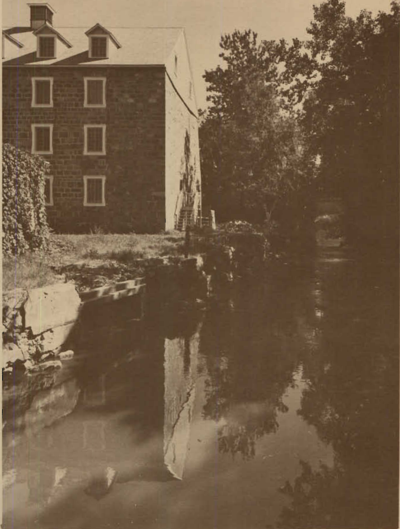
Coin ouest du moulin banal. Le moulin était un centre stratégique de la vie seigneuriale. Celui-ci fut construit en 1842, par Edward Ennis de Saint-Pascal Photo: QQIBC
