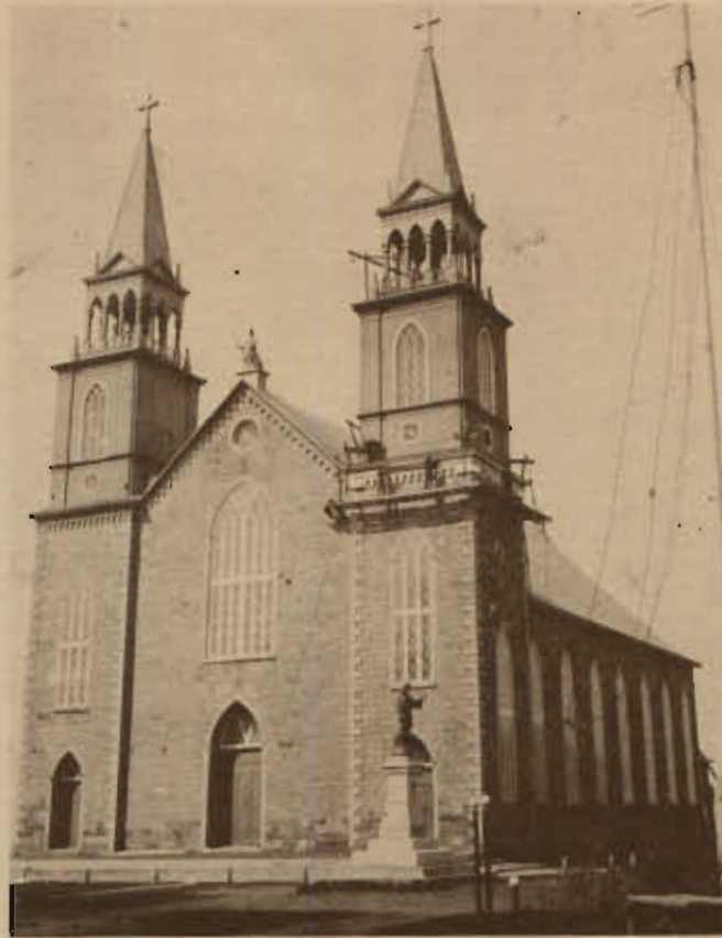
On commence la restauration des clochers. A l'avant, on remarque le monument du Sacré-Coeur érigé depuis 1919. Photo: collection privée
