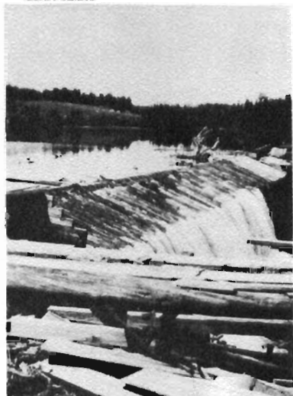
L'écluse actionnant l'ancien moulin à carde, au rang 6.
