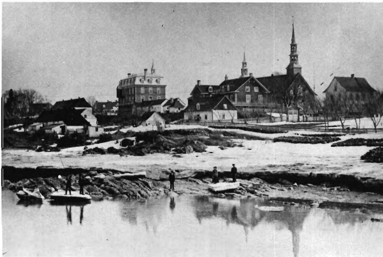
Prise du quai, une vue de la grève, après 1903.
