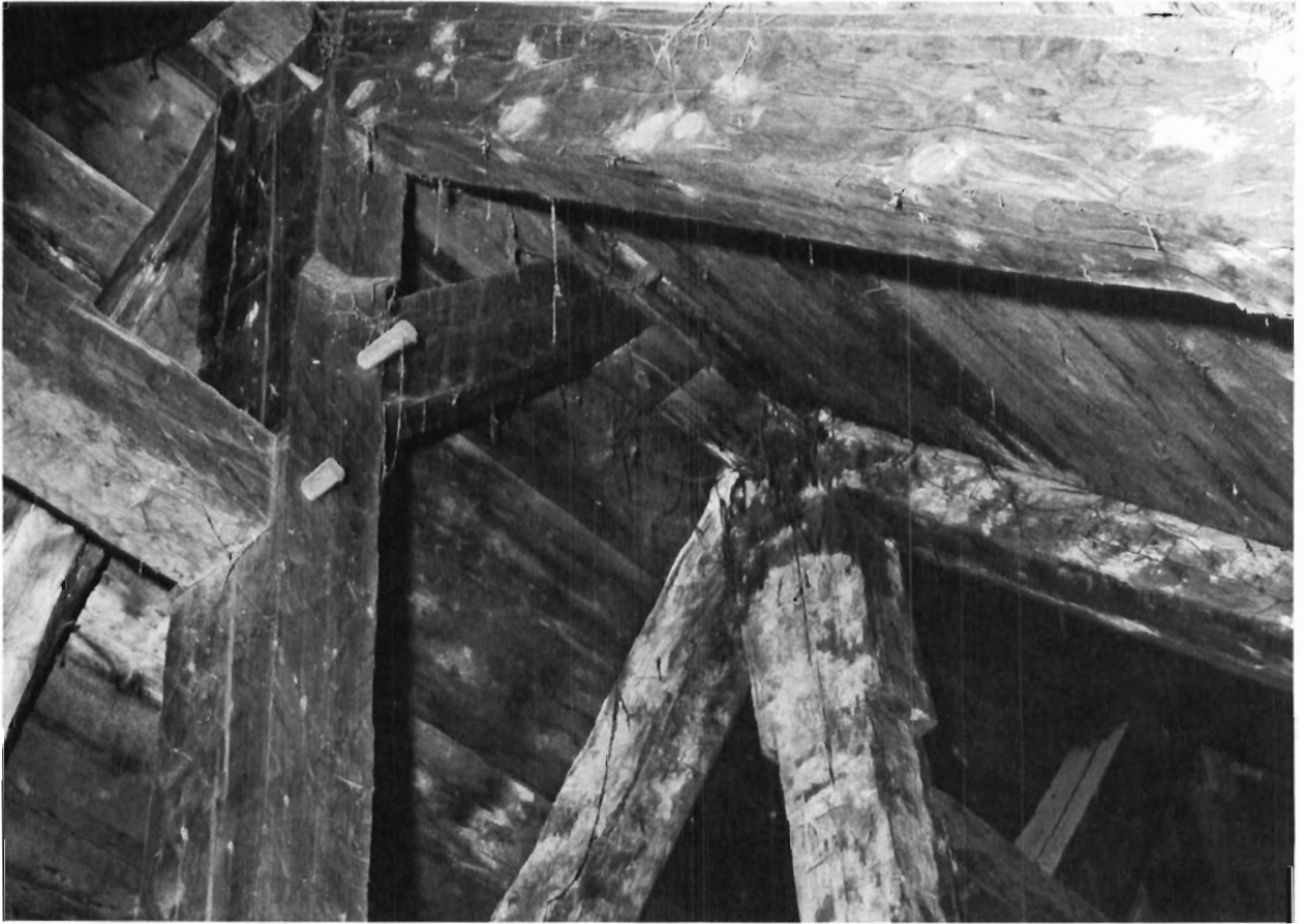
Aiguille et chevrons enduits de mortier, dernier chevron au portail ouest de l'église construite en 1779. Photo: Conrad Toussaint.
