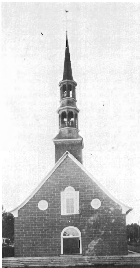
Façade de l'église, 1917. Photo: Archives nationales du Québec, collection initiale.
