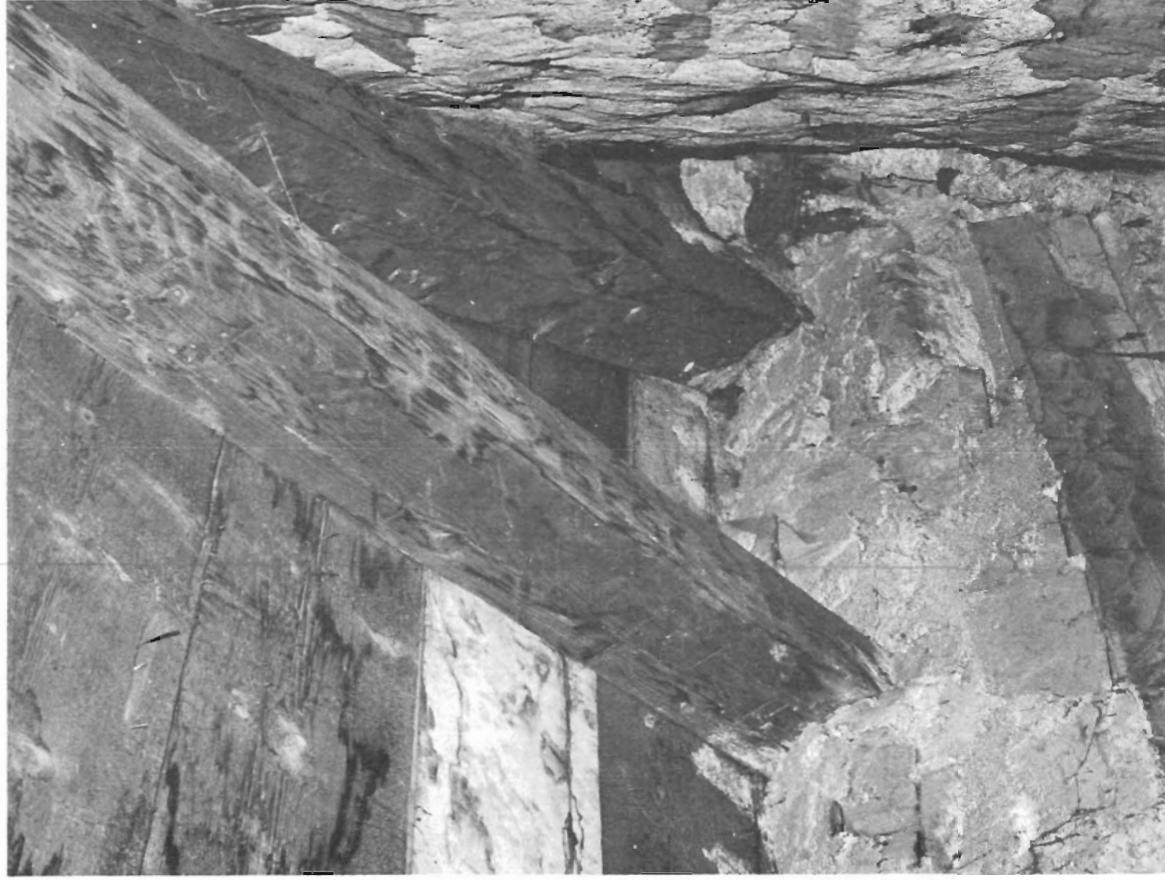
Chevrons de la sacristie liés dans le mortier, près de la sablière. Photo: Conrad Toussaint.
