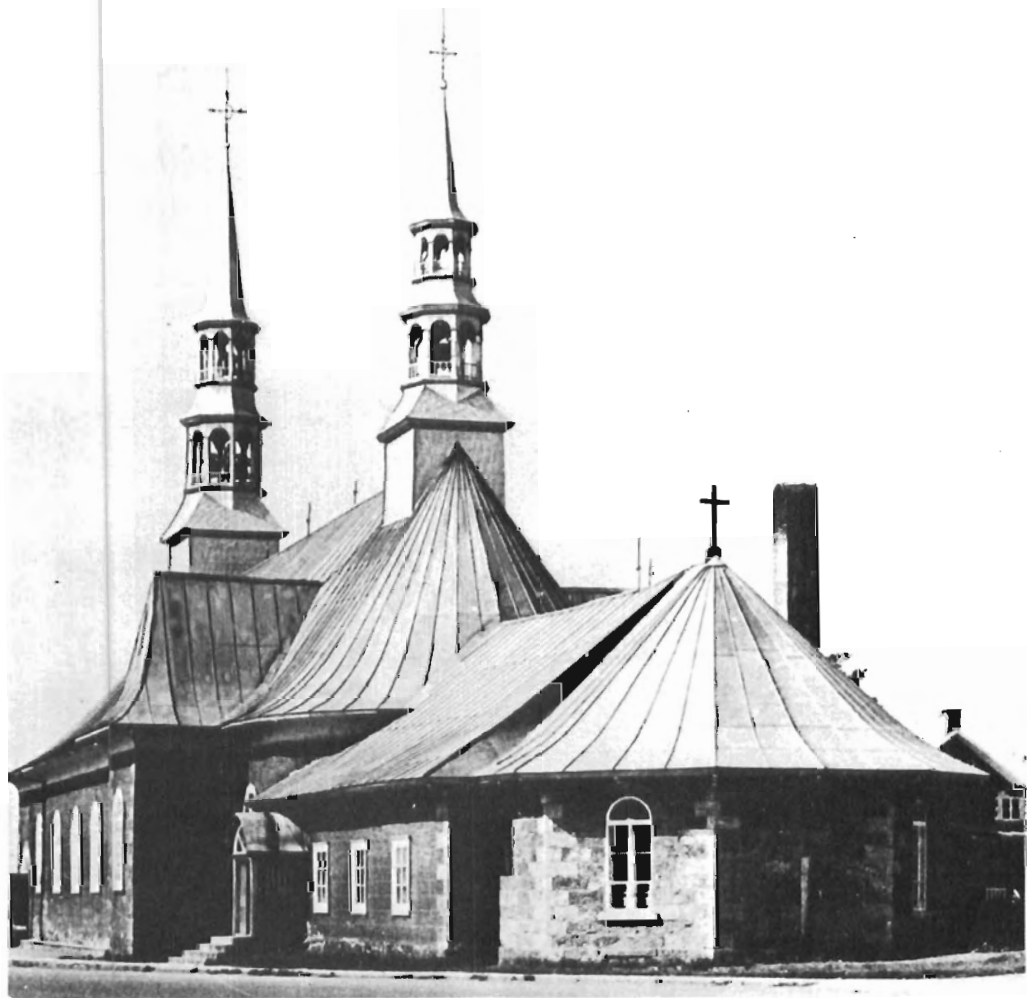
Extérieur de l'église vers 1945, avant le décapage des murs de pierre. Photo: Inventaire des Biens culturels du Québec.
