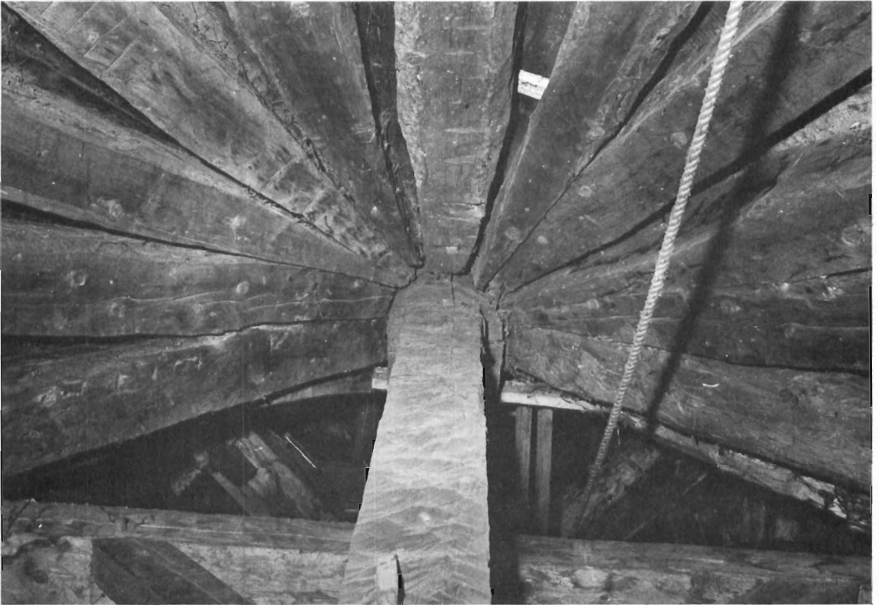
Chevrons formant la pyramide de l'abside au-dessus du sanctuaire. Photo: Conrad Toussaint.
