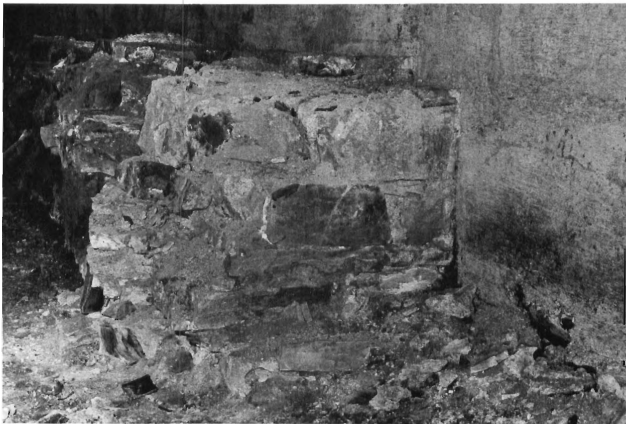
Vestiges du solage de l'église construite en 1779, portail ouest. Photo: Conrad Toussaint.
