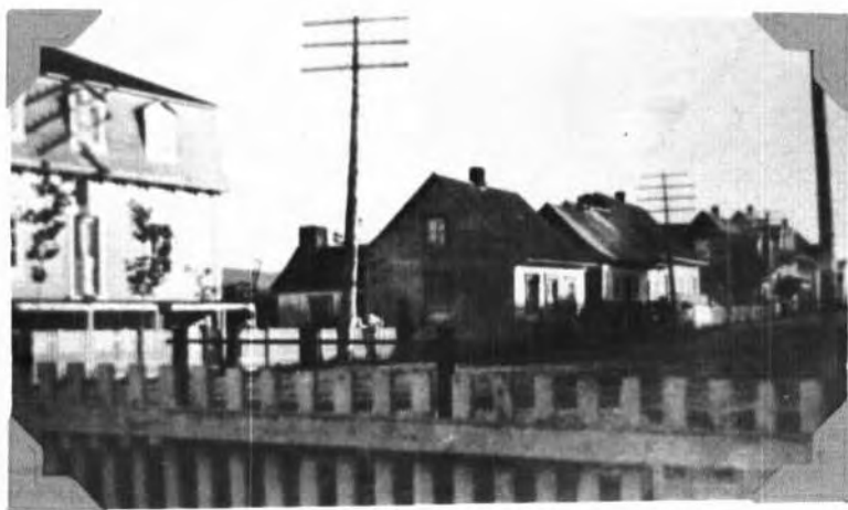
Partie sud-est du village
