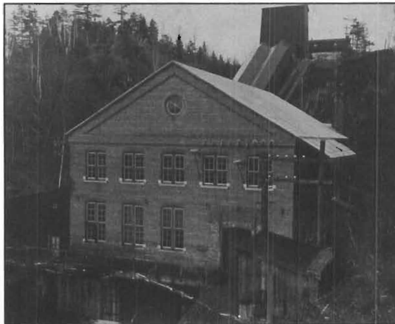
Extérieur de la Centrale électrique «Quebec Power». Collection: Jacques Demers. Collaboration: Société historique St-Nicolas-Bernières.
