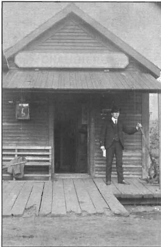
Première gare construite à même un wagon. Source: Livre du 50 e anniversaire de Saint-Rédempteur
