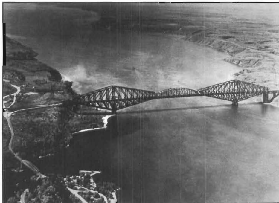
Vue aérienne du pont de Québec et du pont Garneau avant 1955 Collection: Raymond Gingras. Collaboration: Société historique de St-Nicolas-Bernières.
