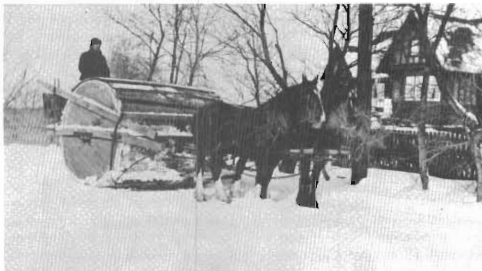
Cette photo date probablement des années 1915. Elle présente l'entretien des chemins d'hiver et les équipements de l'époque. Selon un témoignage, " le rouleau servait à taper la neige au lieu de l'enlever. Il n'a pas servi longtemps car pour une bonne circulation dans les rues, la neige doit être déblayée ".
