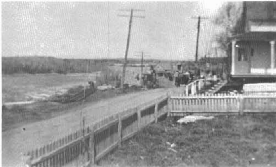
Photo prise entre 1930-1932. Réparation près du chemin Saint-Augustin.
