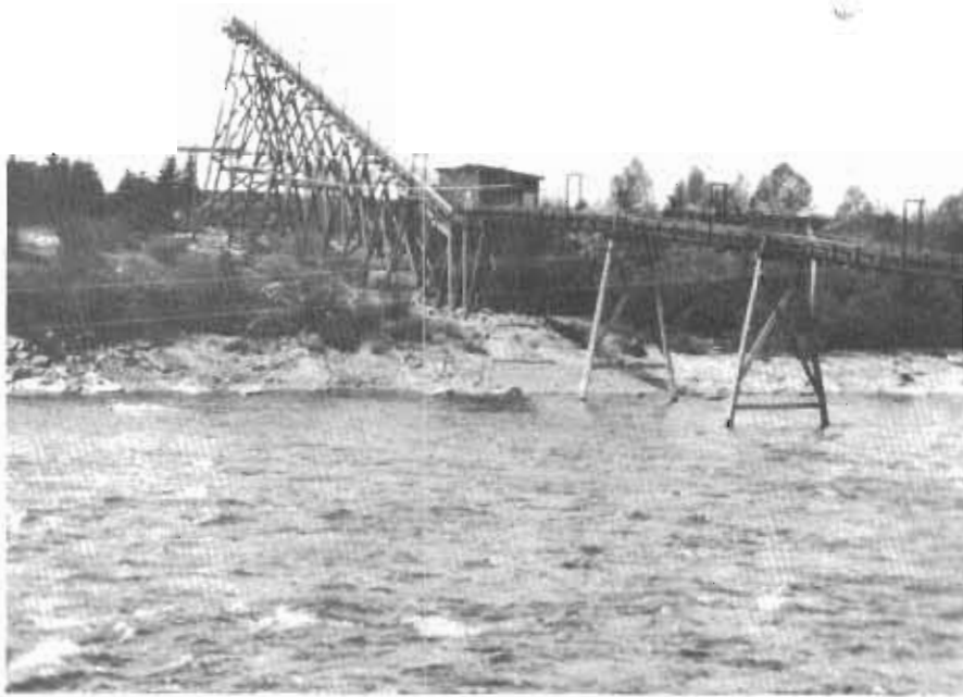
Une photo prise lors de la construction de la chaîne sans fin conduisant les écorces de l'autre côté de la rivière.
