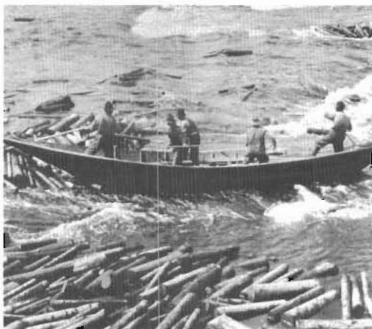
Un canot de "drave" sur la rivière Chaudière.
