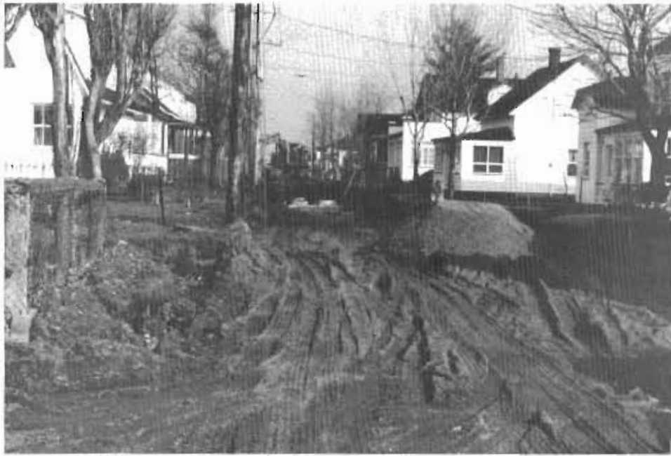
Photo prise en octobre 1982. Travaux d'aqueduc effectués sur la rue Sainte-Hélène.
