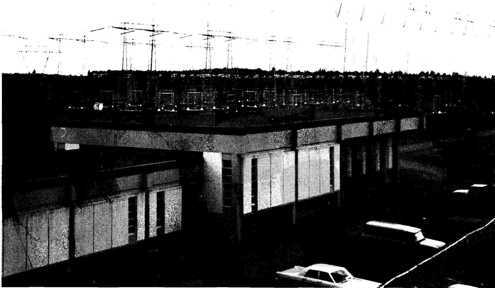
Edifice abritant les commandes et différents appareils de mesure, que surveillent les opérateurs 24 heures par jour.
