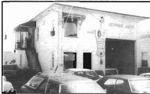
2 e garage construit en 1968.
