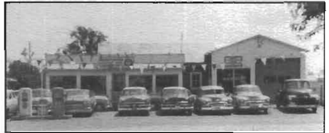
1 er garage construit en 1958.
