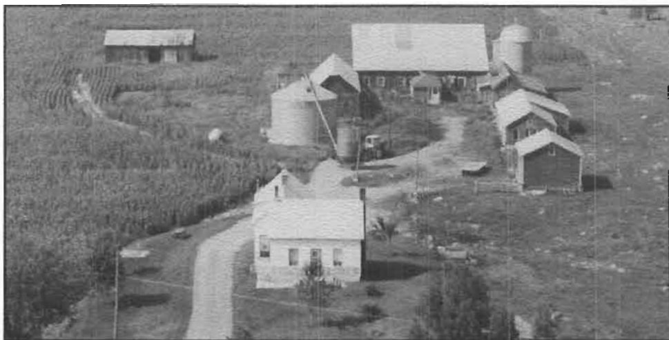
Commerce et résidence situés au 605, rang Saint-Charles, Saint-Chrysostome.
