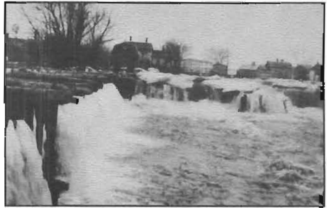
Barrage sur la Rivière-des-Anglais (1920).
