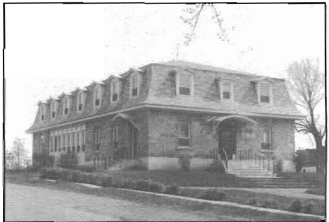
Presbytère rénové en 1962
