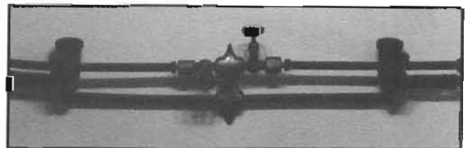
Système d'éclairage au carbure utilisé au couvent, à l'église et dans les commerces (1921).
