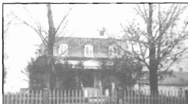
Vue du presbytère et des dépendances
