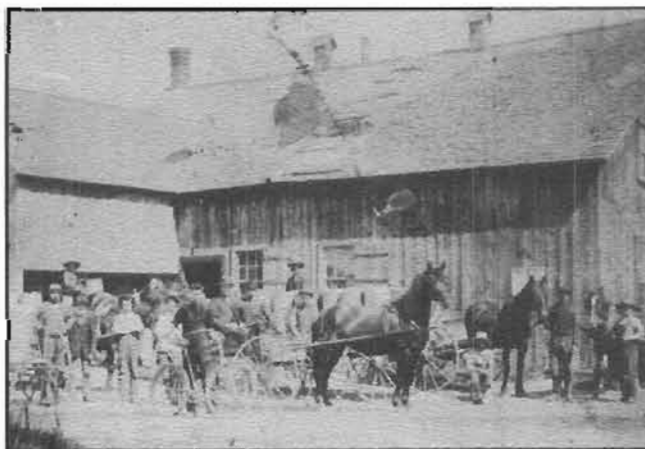
Poste d'écrémage sur Covey Hill.
