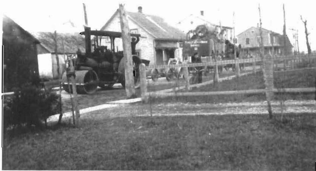
Asphaltage du chemin Pintendre en 1927, avec rouleau à vapeur et concasseur mobile
