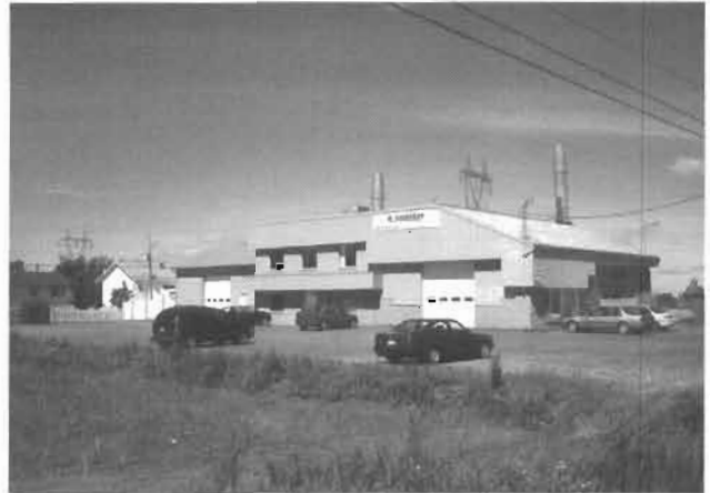
Garage JR Gaudreau inc. après l'agrandissement de 1988
