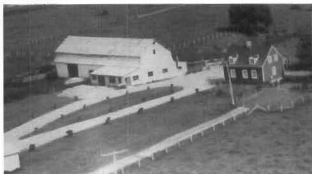
La maison du chemin Ville-Marie et la ferme en 1965
