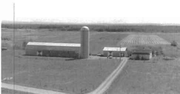
La ferme vers 1976 – La petite maison a été déplacée en 1959, le deuxième étage ajouté en 1964 et le silo érigé en 1975.
