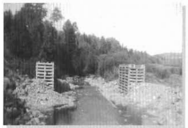
Le bois étant une matière putréfiable, l'entretien et la rénovation des nombreux ponts de Saint-Nazaire requéraient un suivi constant.
