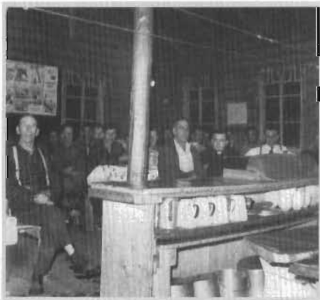
Messe au chantier d'Elzéar Béchard - novembre 1956
