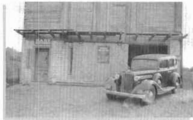
Le premier garage de Léopold Lachance était situé sur le site actuel de la résidence de Donald Pelchat.
