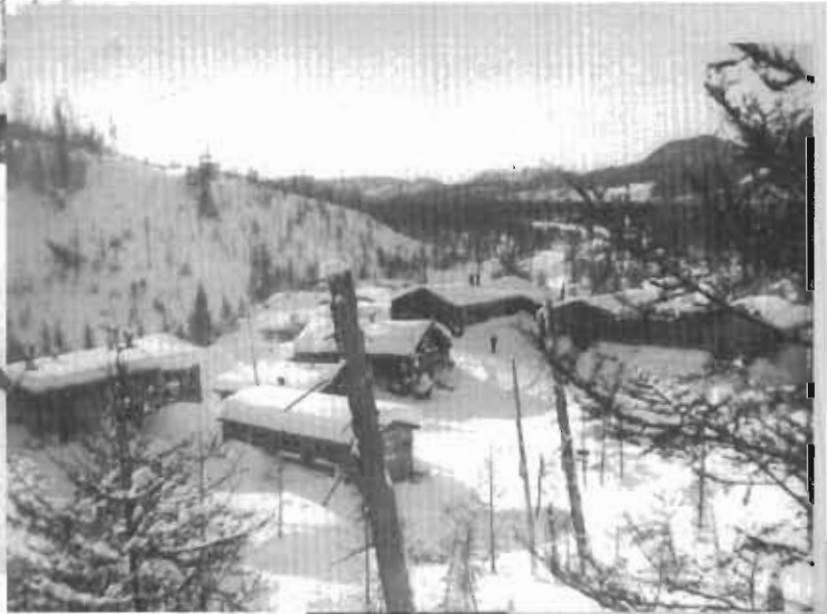
Féerie photographique prise au chantier d'Elzéar Béchard le 1 er février 1951
