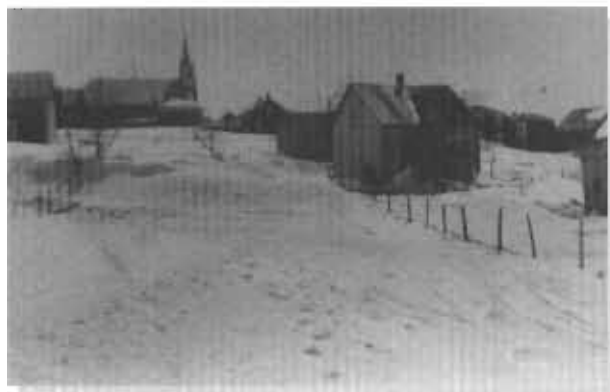
Sur cette photographie exceptionnelle prise au mois de mars 1947, quelques mois avant l'électrification de notre municipalité, on remarque l'absence de ligne électrique.
