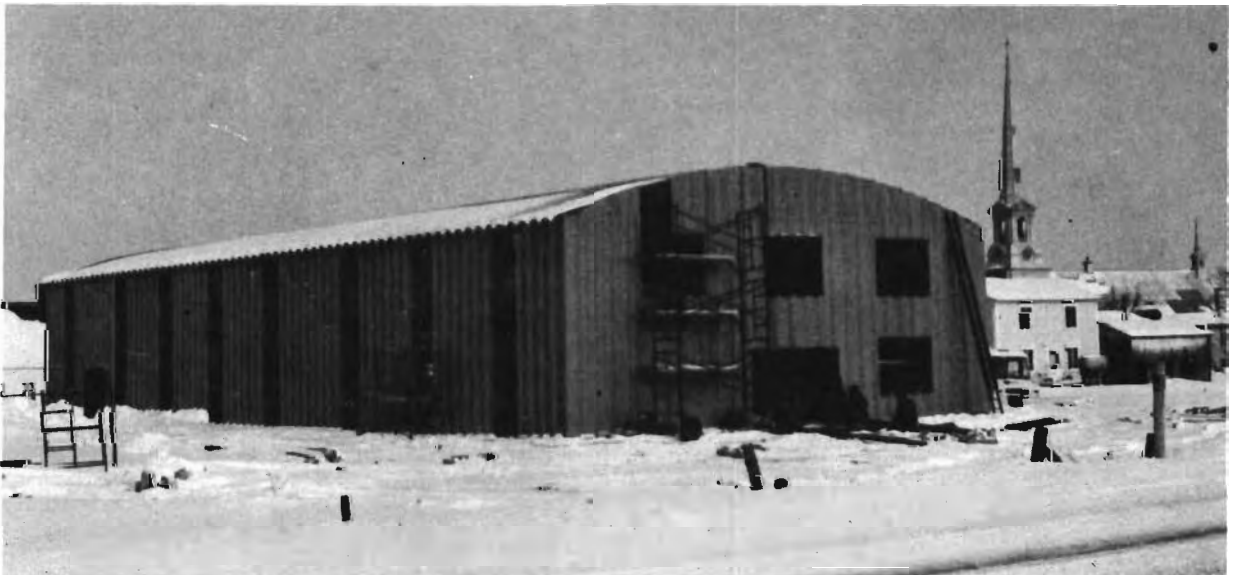
Le Centre Communautaire de Saint-Michel en construction, 1976-1977.
