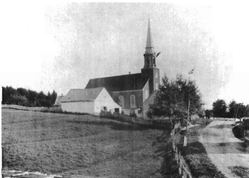
La première église de St-Damien, terminée en 1883.
