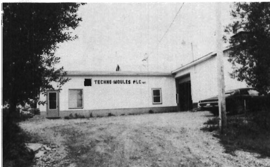
Vue extérieure de l'usine.
