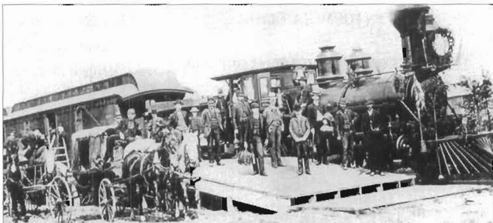
La première locomotive qui s'avança sur les rails fut accueillie avec joie Source : les Mémoires du Québec
