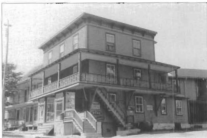
Le magasin Émile Asselin après les rénovations de 1950
