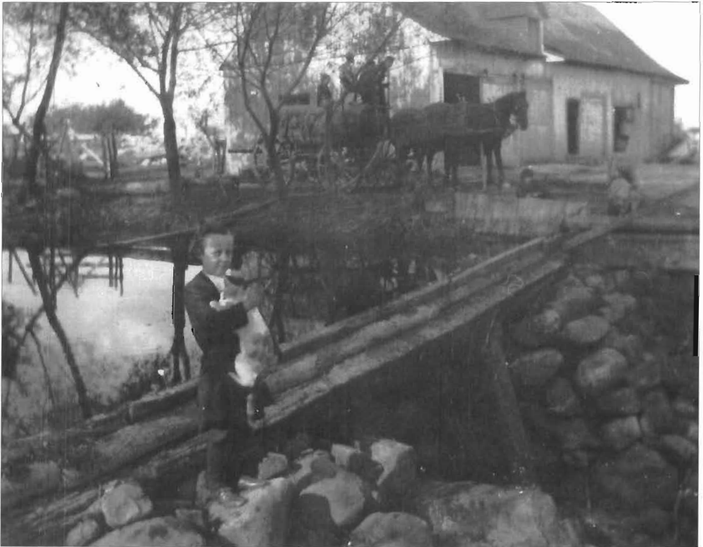
Monsieur Antonio Chabot photographié sur le barrage de l'écluse près de la grange de son père — Barrage en billots
