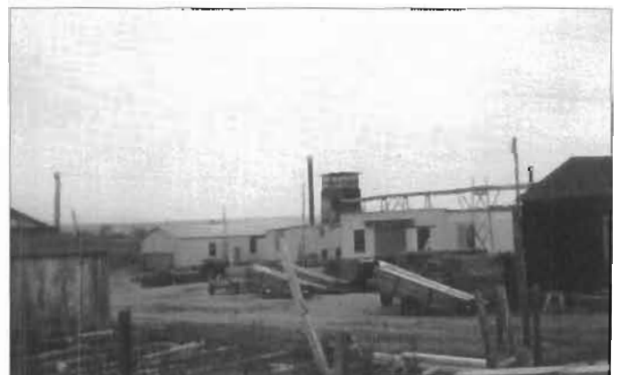
Ensemble des installations
