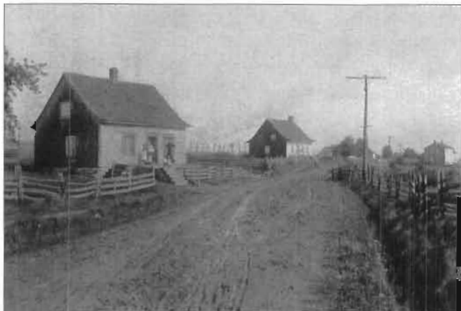
Sortie Est du village, 1915 avant la macadamisation Maisons: O. Couture, Jos Nadeau, F. Gagnon Ligne téléphonique en opération, mais l'électricité n'est pas arrivée
