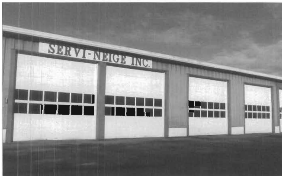
Garage chauffé de 50 pieds par 40 pieds muni de 7 grandes portes, 1998 Photo : Mme S. Bonneau
