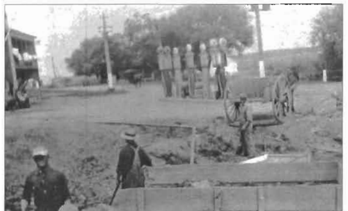
On creuse les fondations de la nouvelle maison de Joseph Labrie
