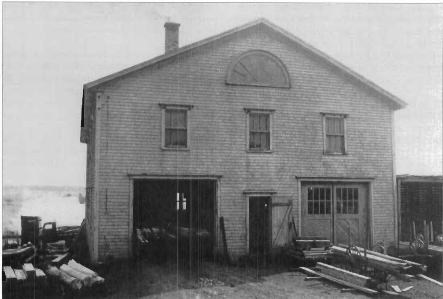
Moulin à scie fonctionnant encore aujourd'hui avec une bouilloire (vapeur). Construit en 1937 par M. Marius Labrie et opéré depuis 1982 par son fils Charles.
