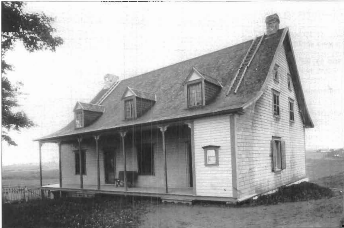
Photo de la maison du notaire et seigneur Louis Turgeon rang Sud de la rivière Boyer, construite probablement avant 1800
