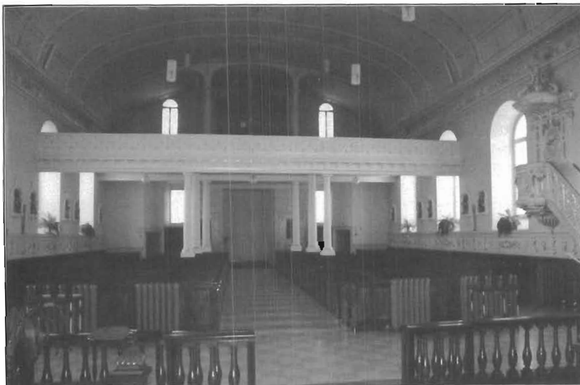
Vue de la nef après l'enlèvement des bergères en 1997
