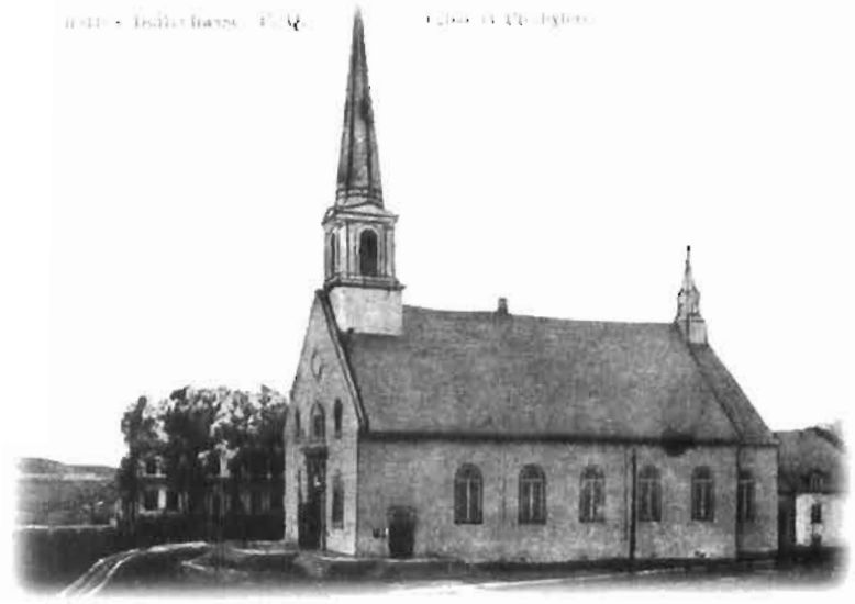
Photo prise avant le remplacement des niches de la façade par des fenêtres, en 1911 Photo Circa 1900
