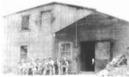
À droite: 1ère usine. À gauche: 1er agrandissement.
