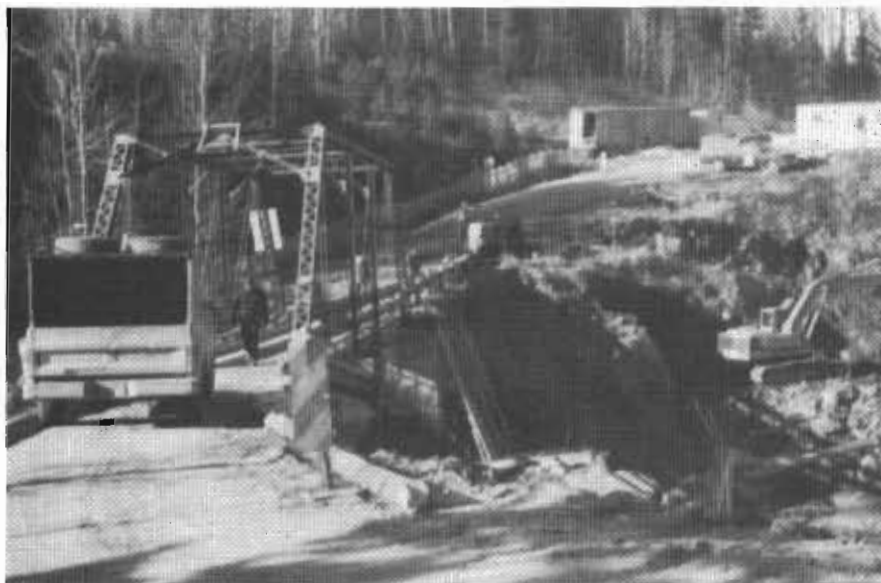
Début des travaux au pont du Gouvernement.
