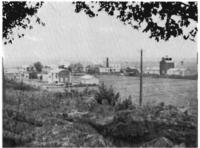
Vue d'ensemble de la gare de La Durantaye
