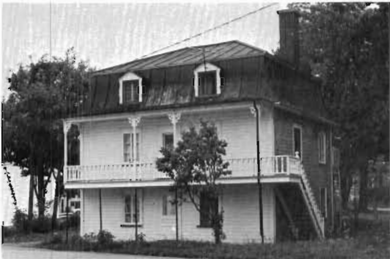
Maison à mansarde de Beaumont
