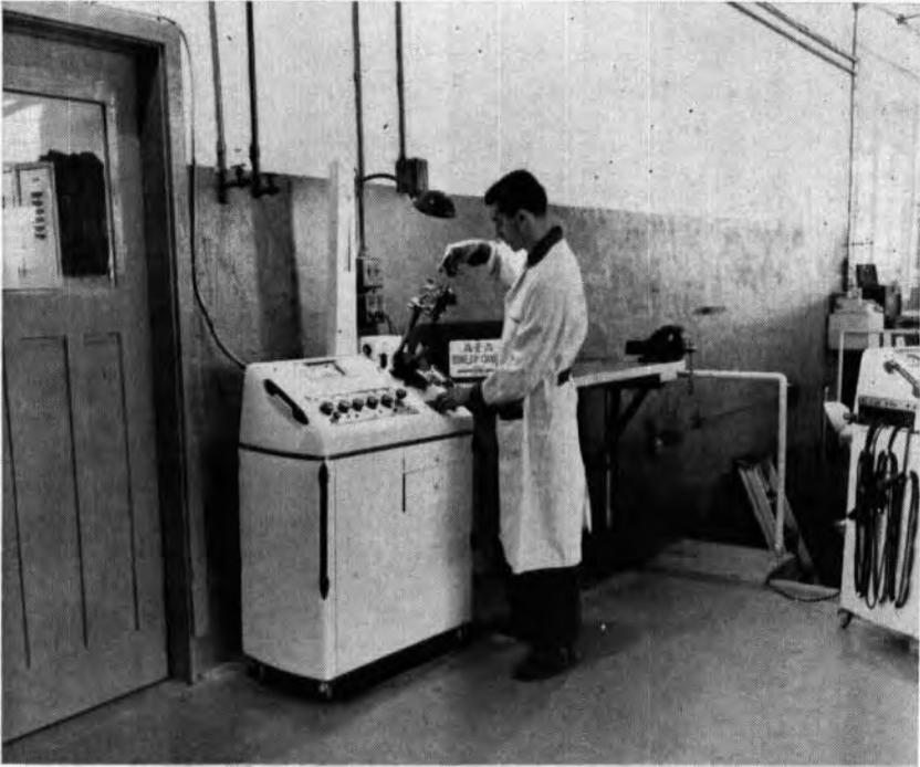
**Technicien ajustant un distributeur sur un stroboscope**
