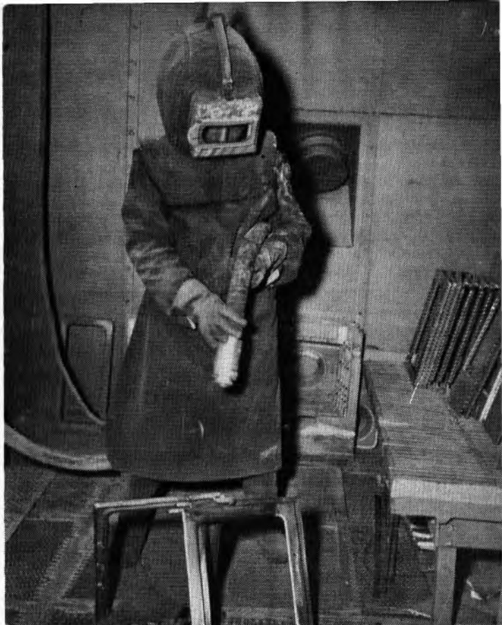
Nettoyage au jet de sable.
