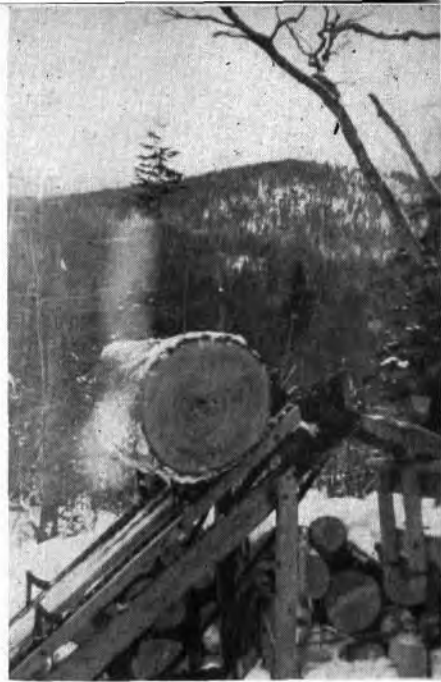
Élévateur pour le chargement du bois franc
