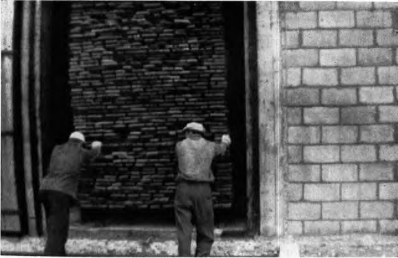
En 1956 on a construit un séchoir unique en son genre dans toute la région. Il s'agit d'un séchoir ultra-moderne avec le bâtiment réservé aux fournaies, construit complètement séparé de l'édifice principal. Comme combustible l'on emploie les déchets de bois lesquels servent aussi à chauffer toutes les bâtisses.
