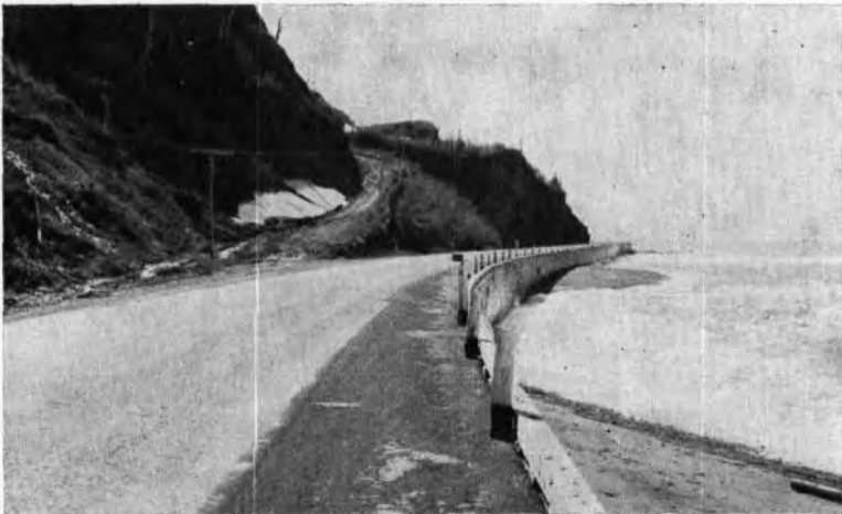
Voici une photo de l'ancien et du nouveau chemin à la Côte du Cap
