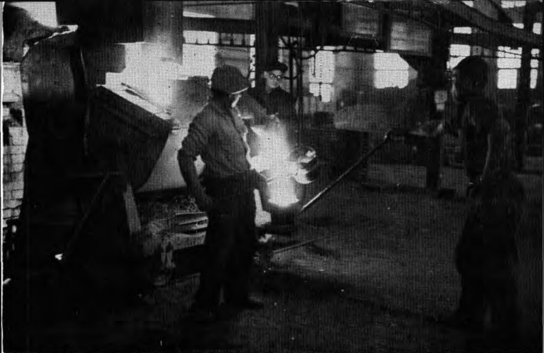
Distribution de la fonte au cubilot.
