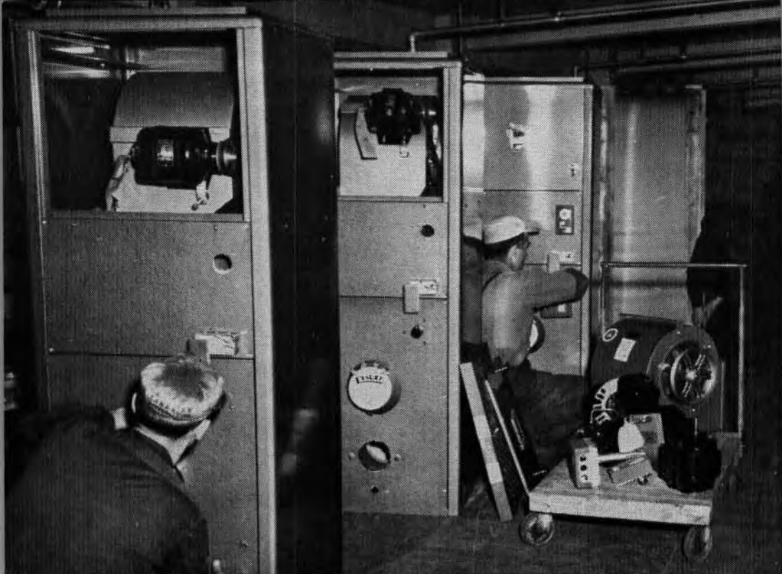
Assemblage d'une unité de chauffage automatique à l'huile
