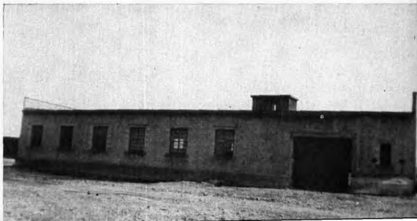
Vue du côté de l'usine
