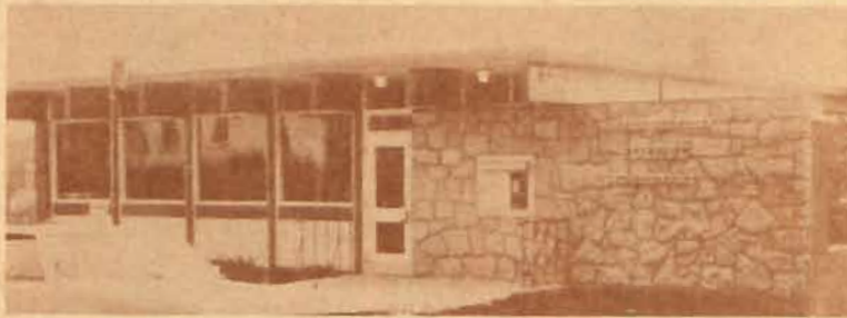
Le bureau de poste Bolduc
